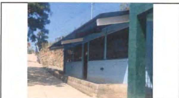
Muro perimetral de malla y reparación de pasillo
