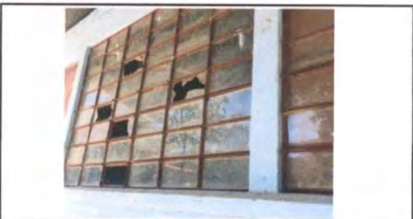
Sustitución de estructura de ventanas y vidrios por ventanas corredizas
