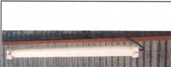
Sustitución de Lámparas y reparación de cableado eléctrico
