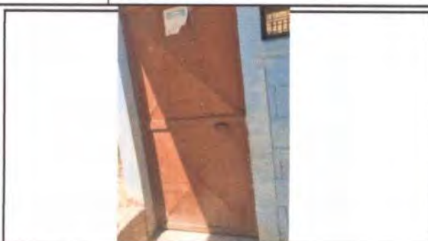
Mantenimiento a estructura de puertas
