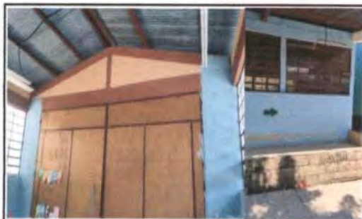
Pintura en exterior e interior
