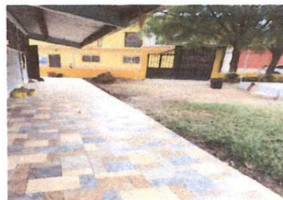
Foto 2: Sustrucción de puerta de maya por portón de metal.
