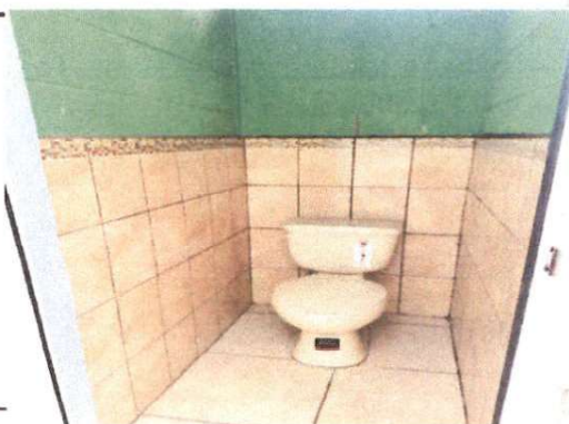
Foto 6: Sustrucción de accesorios inodoro ( contra llave, manguera .)
