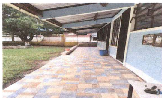
Foto 5: Sustrucción de piso de concreto por piso de patio en el corredor.
