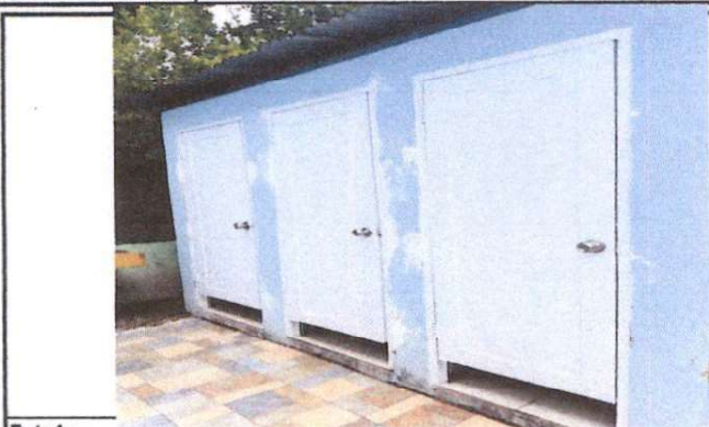
Foto 1: Sustrucción de puertas.
