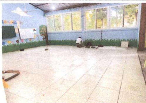
Foto 4: Sustrucción de piso de concreto por piso cerámico.
