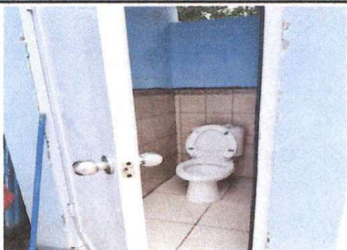
Foto1: Sustitución de inodoro.
