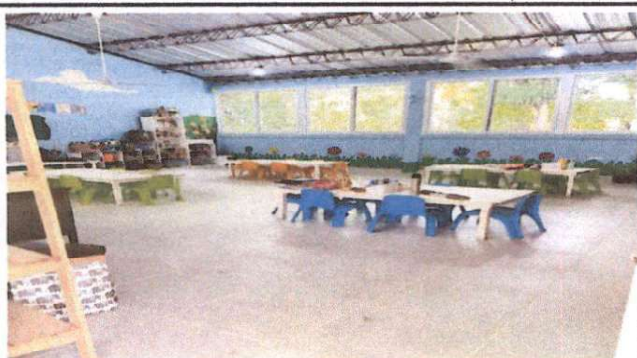
Foto 3: Sustrucción de ventanas de vidrio por ventanas de PVC.
