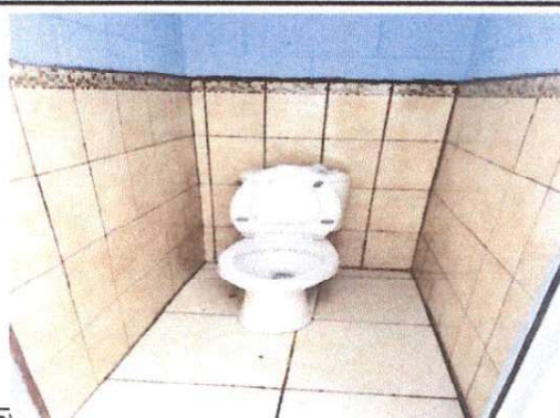
Foto 2: Colocación de azulejo de baño.
