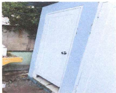
Foto 1: Sustitución de puertas.
