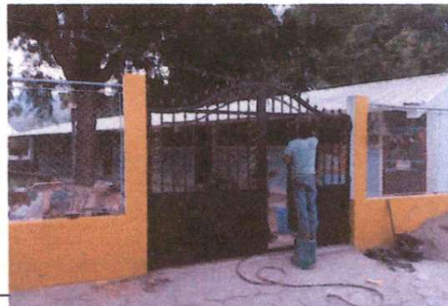
Foto 2: Sustitución de puerta de maya por portón de metal.
