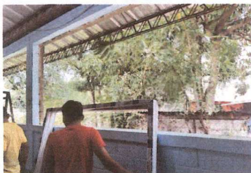
Foto 3: Sustitución de ventanas de vidrio por ventanas de PVC.
