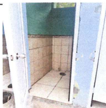
Foto 6: Sustitución de accesorios inodoro ( contra llave, manguera .)
