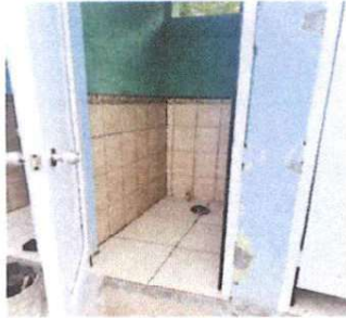
Foto1: Sustitución de inodoro.
