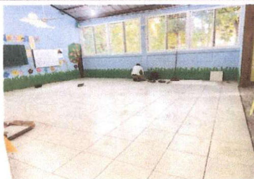
Foto 4: Sustitución de piso de concreto por piso cerámico.
