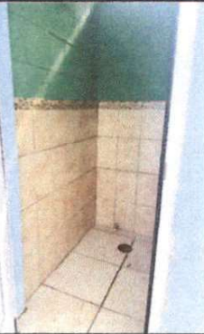
Foto 2: Colocación de azulejo de baño.
