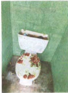
Foto 7: Sustrucción de inodoros
