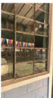
Foto 3: Sustitución de ventana de metal de vidrio por ventana de pvc
