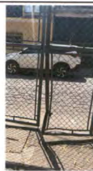
Foto 2: Sustitución de puerta de malla por una puerta de metal
