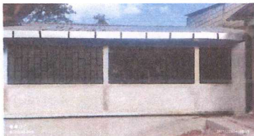
Sustitución de balcones
