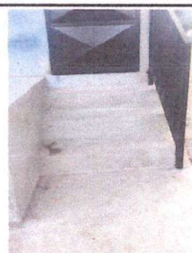
Reparación de banquetas, gradas y fundición de concreto
