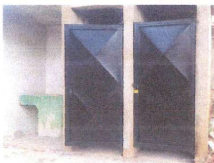
Sustitución de puertas de sanitarios
