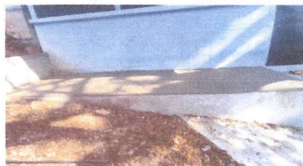
Reparación de banquetas, gradas y fundición de torta de concreto
