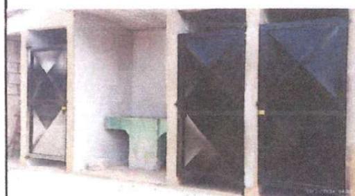
Sustitución de puertas de sanitarios
