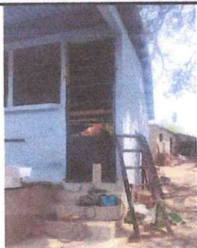
Sustitución de puerta principal de metal.
