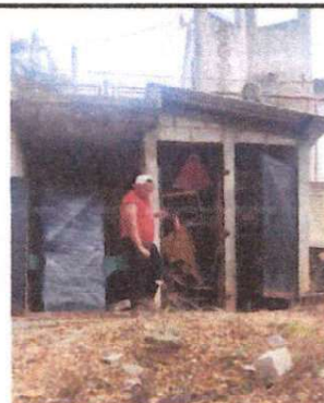
Sustitución de puertas de sanitarios
