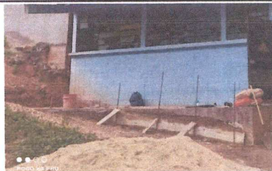
Reparación de banquetas, gradas y fundición de torta de concreto
