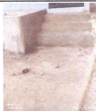
Reparación de banquetas, gradas y fundición de concreto
