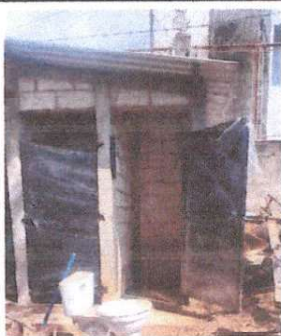
Sustitución de puertas de sanitarios
