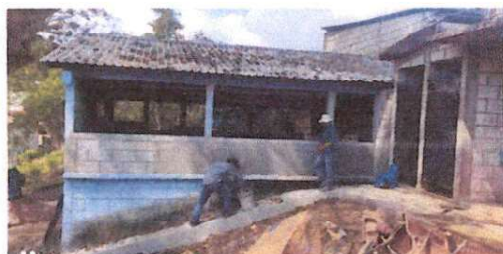
Sustitución de balcones
