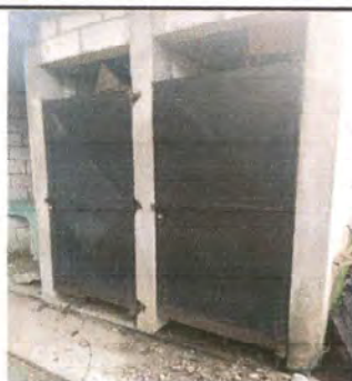
Sustitución de puertas de sanitarios
