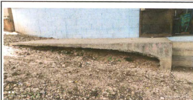
Reparación de banquetas, gradas y fundición de torta de concreto
