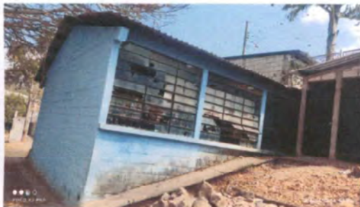
Sustitución de balcones
