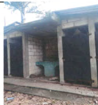
Sustitución de puertas de sanitarios
