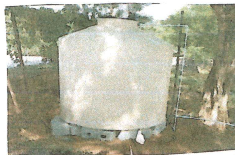
Foto 6: Sustitución de Rotoplas con sus Accesorios y tubería
