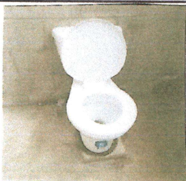
Foto 5: Sustitución Inodoros con sus Accesorios
