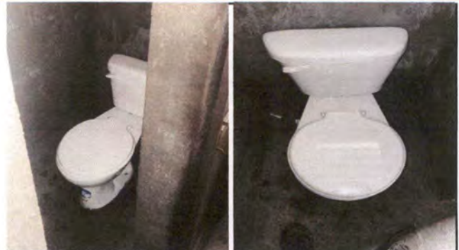
Foto 2: Sustrucción e instalación de servicios sanitarios y sus accesorios
