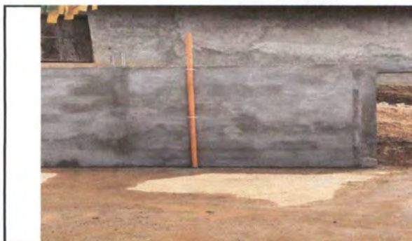
Foto 5: Sustrucción de tubería de PVC línea principal de aguas negras y limpieza de fosa séptica
