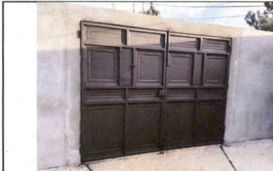
Foto 1: Sustrucción de portón de metal de ingreso al establecimiento
