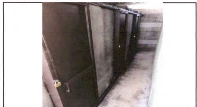
Foto 4: Sustrucción e instalación de puertas de metal en baños
