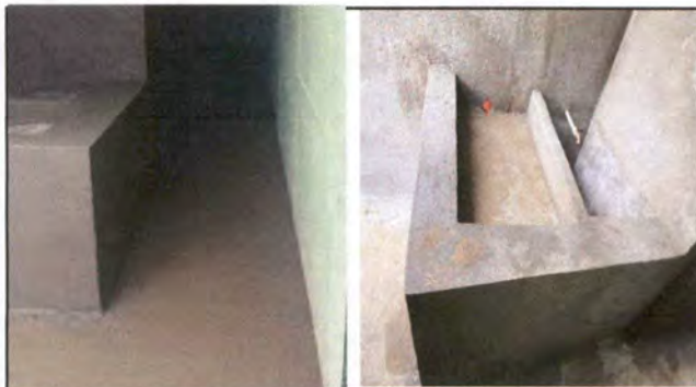
Foto 3: Sustrucción de piso en baños e instalación de pila
