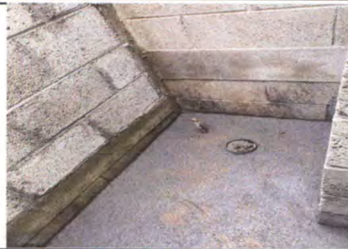
Foto 2: Sustrucción e instalación de servicios sanitarios y sus accesorios
