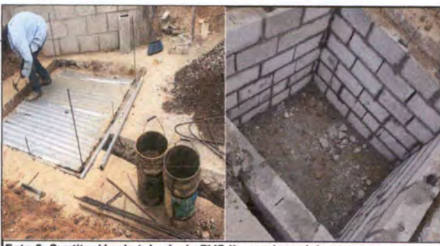
Foto 5: Sustrucción de tubería de PVC línea principal de aguas negras y limpieza de fosa séptica
