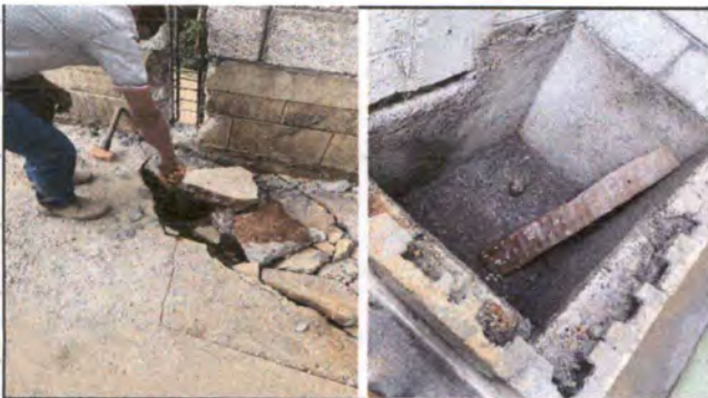
Foto 3: Sustrucción de piso en baños e instalación de pila
