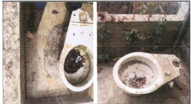
Foto 2: Sustitución e instalación de servicios sanitarios y sus accesorios
