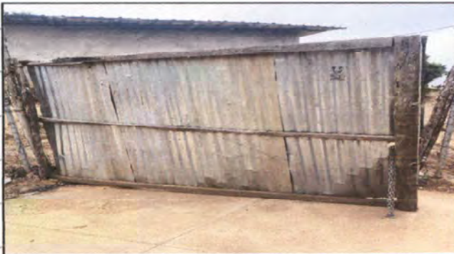
Foto 1: Sustitución e instalación de portón de metal de ingreso al establecimiento
