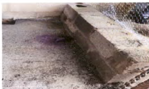
Foto 5: El muro perimetral necesita ser reparado desde su cimientos
