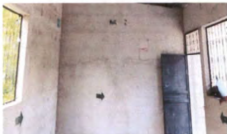
Foto1: Los muros necesitan repello, cernido y pintura para tener un ambiente agradable
