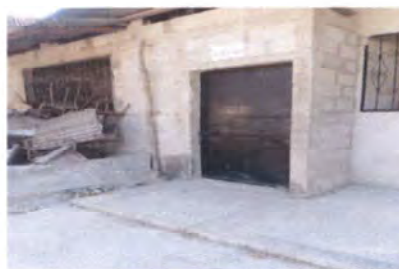
Foto 6: Los muros necesitan repello, cernido y pintura
