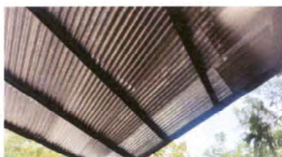
Foto 5: El techo necesita reparación ya que la lamina y la estructura esta deteriorada
