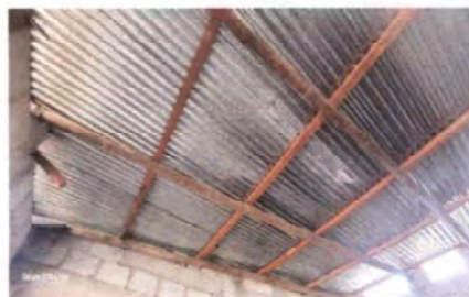
Foto 2: Sustitución de madera por estructura metálica
