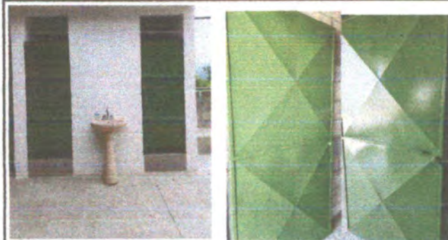
Foto 4: Mantenimiento de puertas de aulas y baños total 4 puertas
