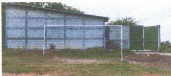
Foto1: Mantenimiento de porton, Reparación de muro
