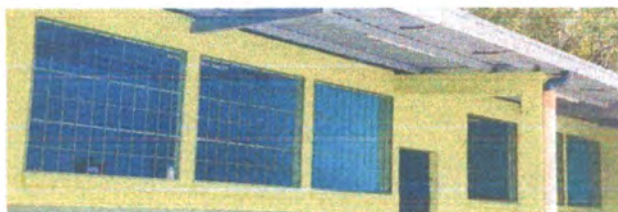
Foto 3: Mantenimiento de balcones y ventanas
