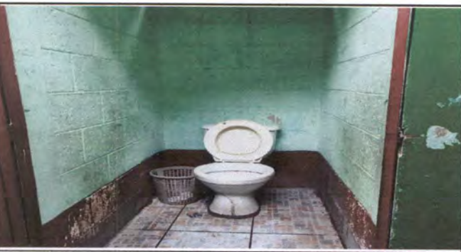
Foto 5: Sustitución de accesorios inodoro (contra llave, tubo de abasto y tanque), Sustitución inodoros
