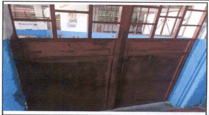
Foto 2: Mantenimiento a estructura (lijado, cambio de tubo, cepillado, sujeciones, aplicación de pintura) Puertas de metal
