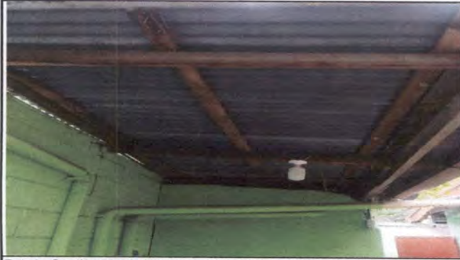
Foto 1: Sustitución de lámina, por lámina troquelada aluzinc calibre 26, Sustitución de elementos de fijación y Sustitución de estructura de soporte de madera, por metal
