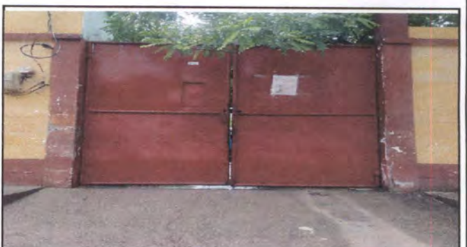
Foto 6: Sustitución de portón
