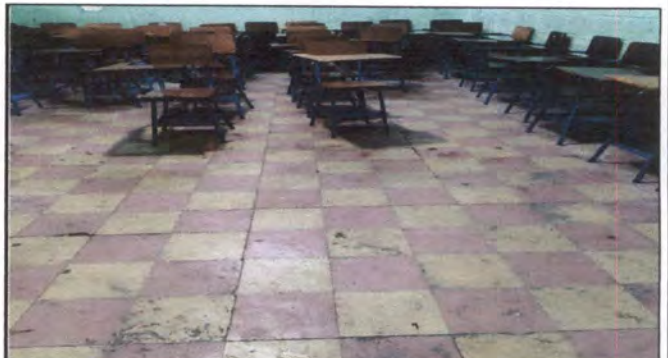
Foto 4: Sustitución de piso de granito
