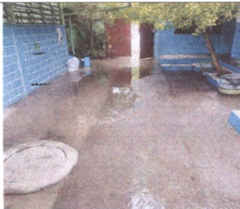
Foto 7: Reparación de planchas de concreto de patio
