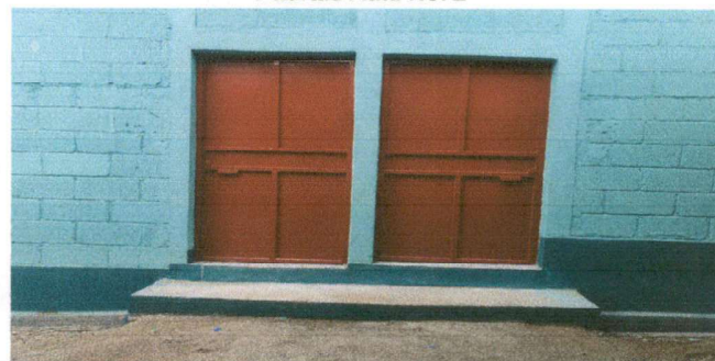
Foto 6: Mantenimiento a puertas metalicas
