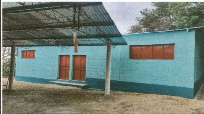
Foto 2: aplicación de 2 capas de pintura en interior y exterior.
