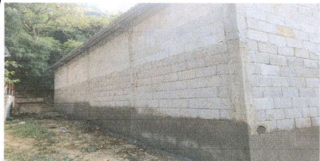
Foto 5: Aplicación de repello solera de humedad.
