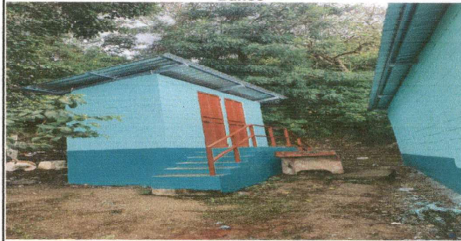
Foto 4: aplicación de 2 capas de pintura en interior y exterior.
