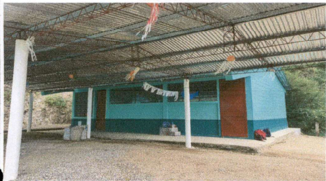
Foto1: aplicación de 2 capas de pintura en interior y exterior.
