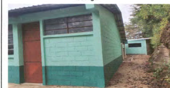
Foto 8: aplicación de 2 capas de pintura en interior y exterior.
