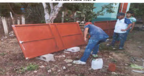
Foto 6: Mantenimiento a puertas metálicas
