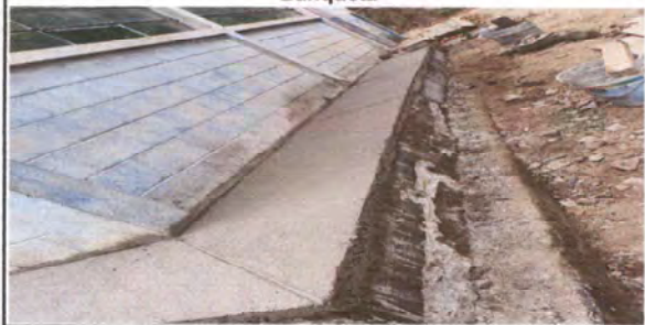
Foto 11: Reparación Banqueta de Concreto
