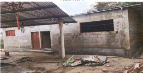
Foto 5: Aplicación de repello solera de humedad.
