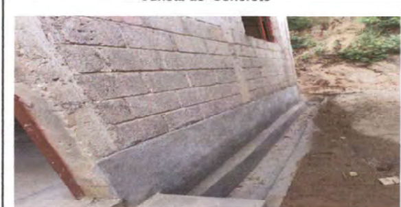
Foto 10: reparación de 7ML de Cuneta de Concreto
