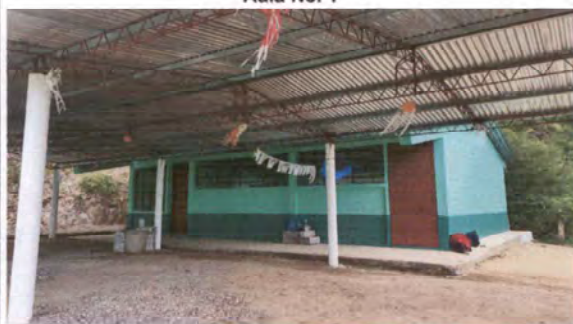
Foto 1: aplicación de 2 capas de pintura en interior y exterior.
