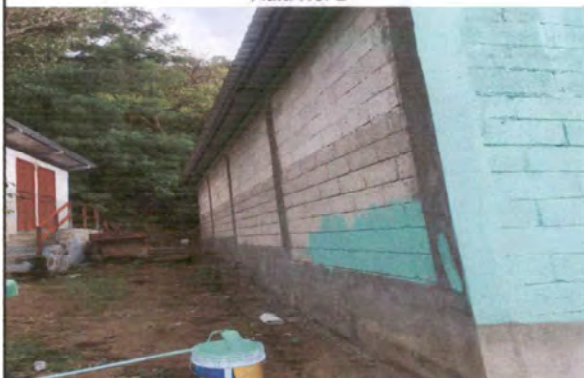
Foto 8: Reparación de repello columnas interiores y exteriores.
