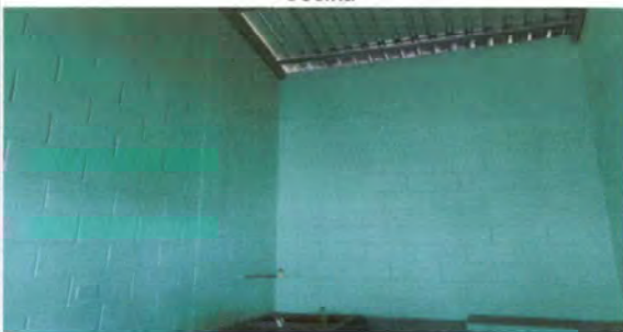
Foto 3: aplicación de 2 capas de pintura en interior y exterior.
