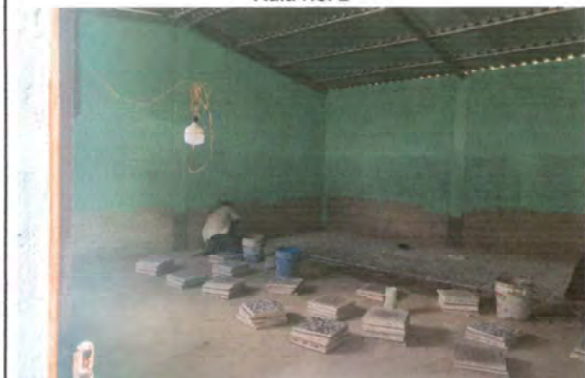
Foto 7: Sustitución de piso de torta de concreto por 85 M2 de piso de granito.
