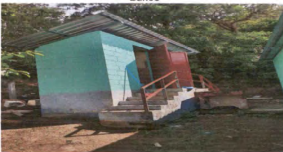
Foto 4: aplicación de 2 capas de pintura en interior y exterior.
