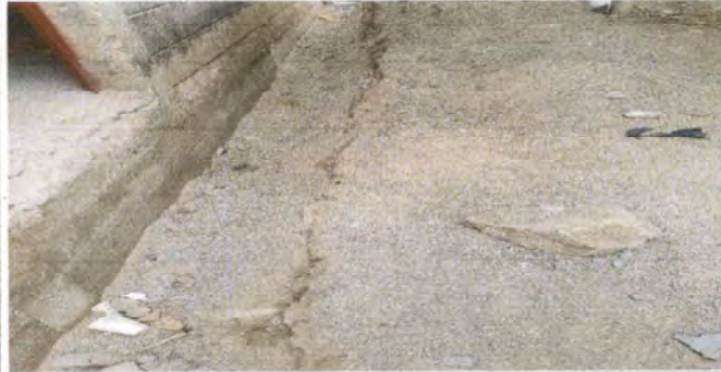
Foto 10: reparación de 7ML de Cuneta de Concreto
