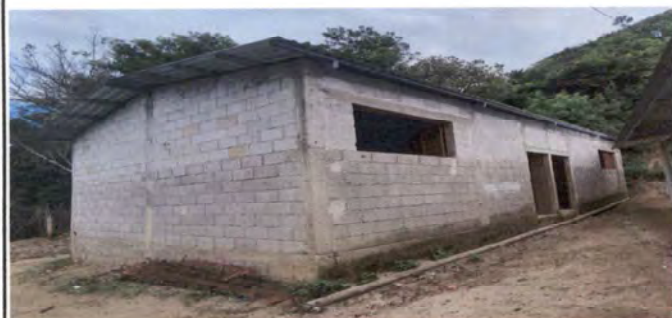
Foto 5: Aula con necesidad de aplicación de repello solera de humedad.
