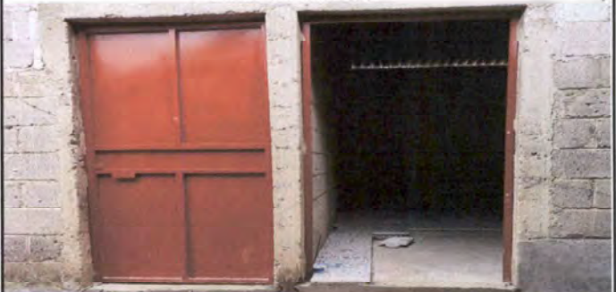
Foto 6: Mantenimiento a puertas metálicas
