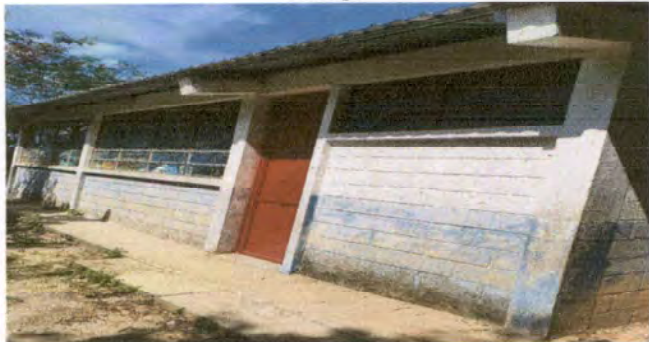
Foto 8: Pintintura en mal estado con necesidad de aplicar pintura en interior y exterior.
