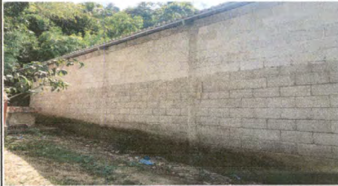
Foto 8: Reparación de repello columnas interiores y exteriores.
