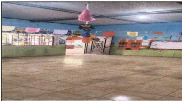
Foto 1: AULA 2 REPARACIÓN DE PISO DE TORTA DE CONCRETO E INSTALACIÓN DE PISO CERÁMICO
