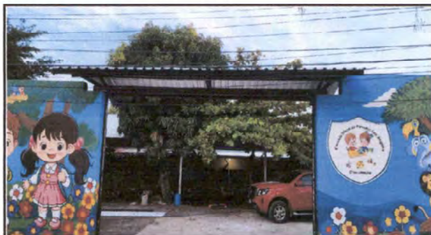
FOTO 8: INSTALACIÓN DE LÁMINA TROQUELADA DE ALUZINC EN TECHO TIPO SOMBRERO DE DOS AGUAS EN PORTÓN DE INGRESO A LA ESCUELA
