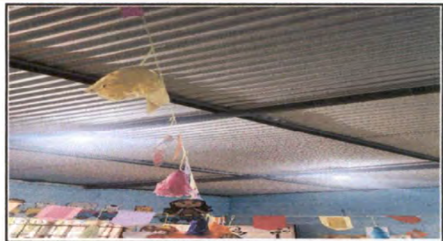
Foto 2: AULA 2 SUSTITUCIÓN DE LÁMINA ACANALADA EN ÁREA DE AULA NO. 2
