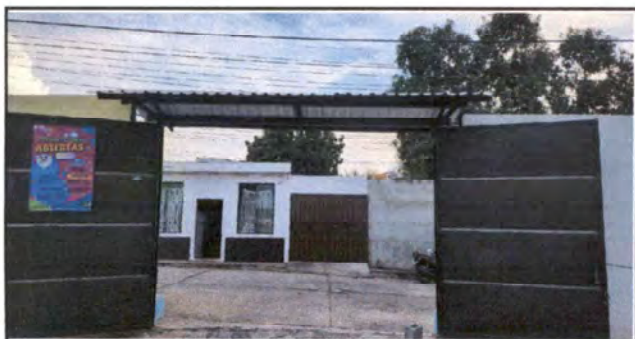
FOTO 9: ELABORACIÓN E INASTALACIÓN DE ESTRUCTURA METÁLICA PARA TECHO TIPO SOMBRERO DE DOS AGUAS EN PORTÓN DE SALIDA DE LA ESCUELA
