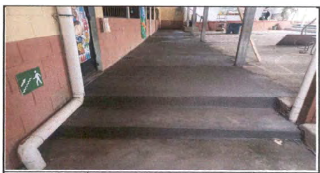
Foto 6: REPARACIÓN DE PLANCHAS DE CONCRETO EN ÁREA DE PATIO CON FUNDICIÓN DE CONCRETO CON ESPESOR DE 5CM
