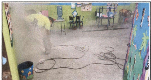
Foto 4: AULA 4 REPARACIÓN DE PISO DE TORTA DE CONCRETO E INSTALACIÓN DE PISO CERÁMICO
