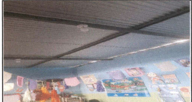
Foto 2: AULA 2 SUSTITUCIÓN DE LÁMINA ACANALADA EN ÁREA DE AULA NO. 2
