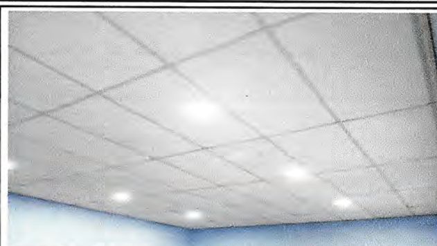
Foto 2: REPARACIÓN DE CIELO FALSO, CABLEADO, LÁMPARAS Y APAGADORES.
