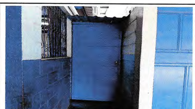
Foto 4: SUSTITUCIÓN DE PUERTA, TECHO, CABLEADO ELÉCTRICO, LÁMPARA, TOMACORRIENTE Y APAGADOR.
