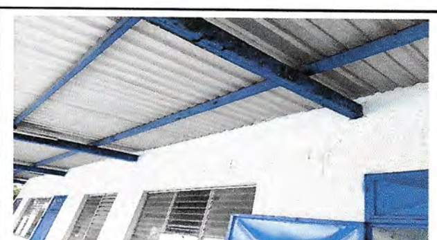
Foto 6: FUNDICIÓN EN PARED
