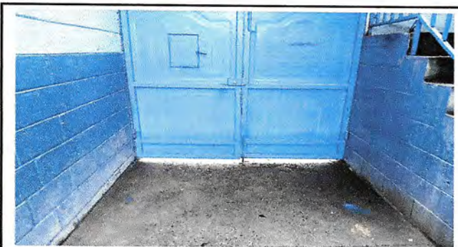
Foto 5: REPARACIÓN DE PUERTA
