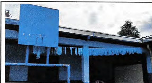
Foto 3: SUSTITUCIÓN DE CANAL DE ALUMINIO, REPARACIÓN Y REFUERZO
