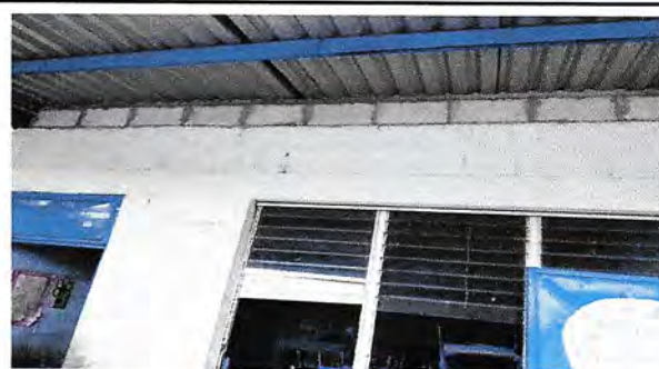
Foto 6: FUNDICIÓN EN PARED
