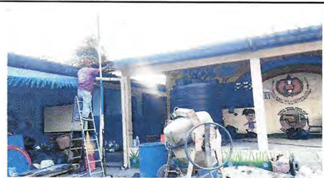
Foto 3: INSTALACIÓN DE CANAL DE ALUMINIO
