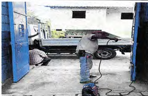
Foto 5: REPARACIÓN DEL PORTÓN
