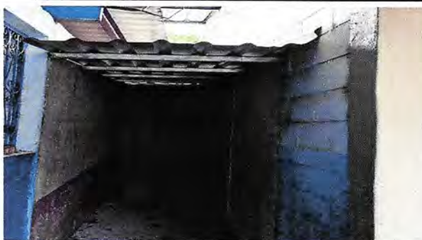
Foto 4: SUSTITUCIÓN DE PUERTA, TECHO, CABLE ELÉCTRICO, LAMPARA, TOMACORRIENTE Y APAGADOR.
