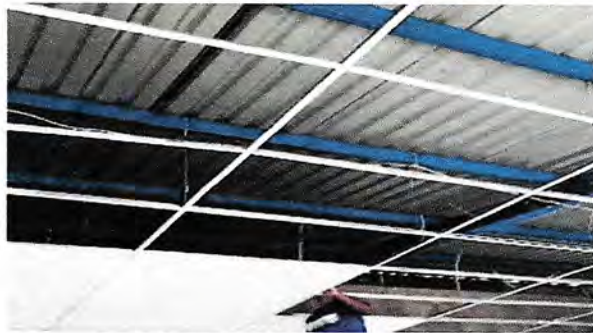
Foto 2: INSTALACIÓN DE CIELO FALSO
