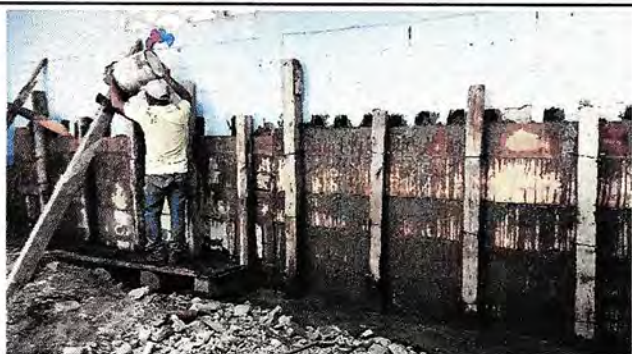
Foto1: FUNDICIÓN DE MURO
