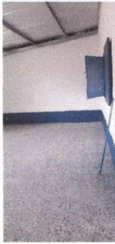
Foto1: Terminación de la colocación del piso en el aula número 1
