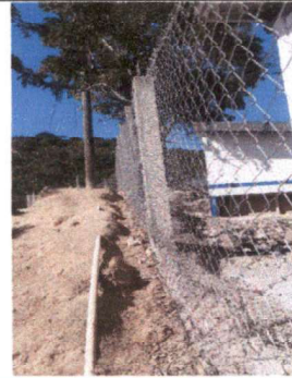
Foto 4: Terminación de la malla del muro perimetral
