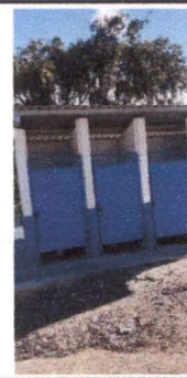
Foto 6: Echada de cemento en los baños números 2
