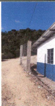
Foto 5: Colocación de la malla perimetral
