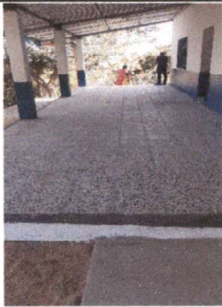
Foto 3: Terminación de la colocación del piso en el corredor
