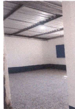
Foto 2: Terminación de la colocación del piso en el aula número 2
