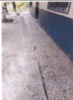
Foto 5: Colocación del piso de granito en el corredor
