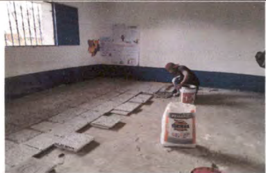
Foto 4: Colocación del piso de cerámica aula número 2.
