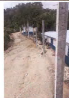
Foto 6: Colocación de los postes
