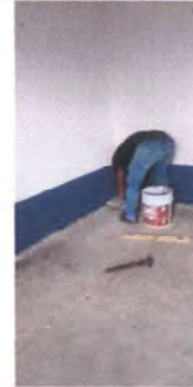
Foto 2: Colocación de la primera pieza de cerámica.
