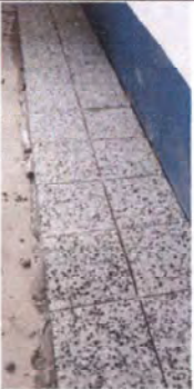
Foto 3: Continuación de la pega del piso.
