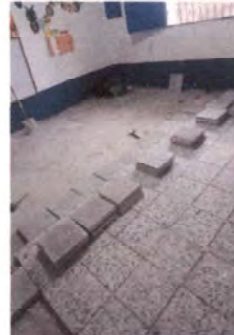
Foto 4: Colocación del piso de granito en el aula número 2
