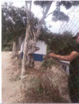
Foto1: Quitada de la malla del muro perimetral
