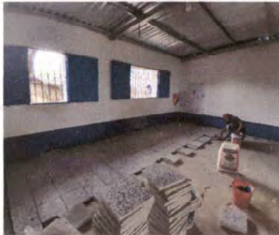
Foto 3: Colocación del piso de granito en el aula número 1
