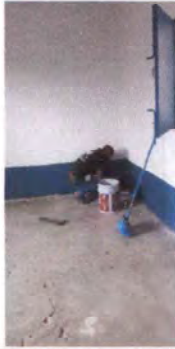
Foto 1: Inicio de la reparación y colocación del piso cerámico en el aula número 2.
