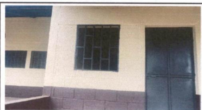
4. MANTENIMIENTO DE BARRANDAS
