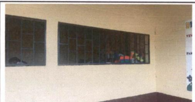
4. MANTENIMIENTO DE BARRANDAS
