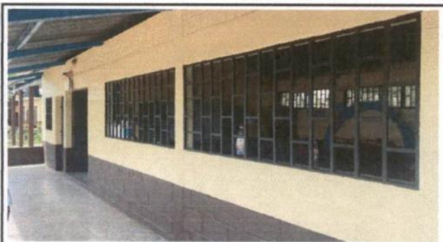
4. MANTENIMIENTO DE BARRANDAS
