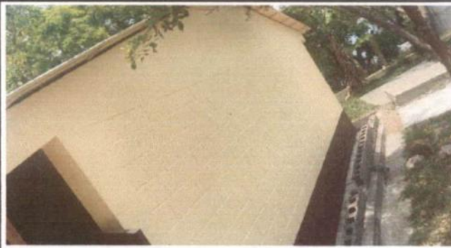
1. PINTURA EN MUROS EXTERIORES E INTERIORES
