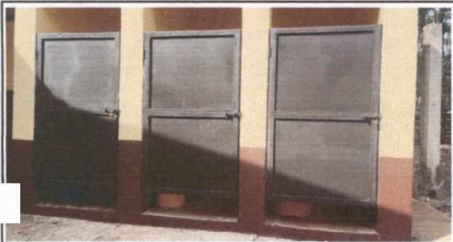
2. PUERTAS DE METAL 2.1 MANTENIMIENTO A ESTRUCTURA (LIJADO, CEPILLADO Y APLICACION DE PINTURA)
