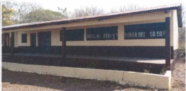
1. PINTURA EN MUROS EXTERIORES E INTERIORES
