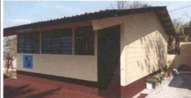
1. PINTURA EN MUROS EXTERIORES E INTERIORES
