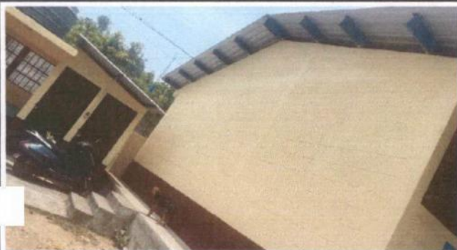
1. PINTURA EN MUROS EXTERIORES E INTERIORES
