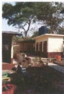
1. PINTURA EN MUROS EXTERIORES E INTERIORES
