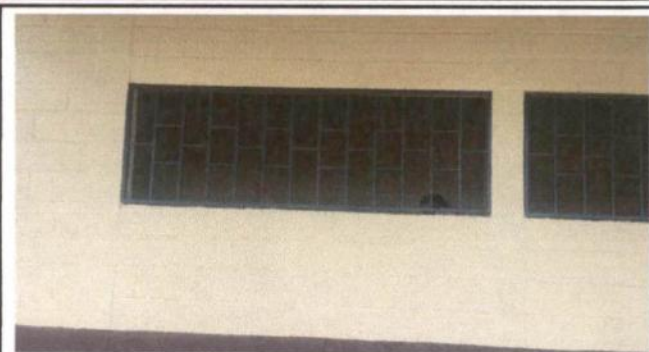
4. MANTENIMIENTO DE BARRANDAS
