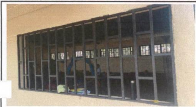
4. MANTENIMIENTO DE BARRANDAS
