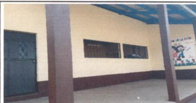
1. PINTURA EN MUROS EXTERIORES E INTERIORES
