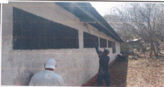
1. PINTURA EN MUROS EXTERIORES E INTERIORES
