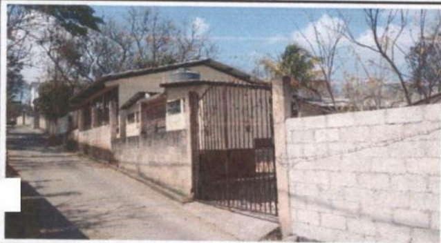
1. PINTURA EN MUROS EXTERIORES E INTERIORES
