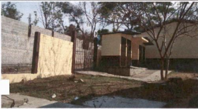
3. MANTENIMIENTO A PORTON
