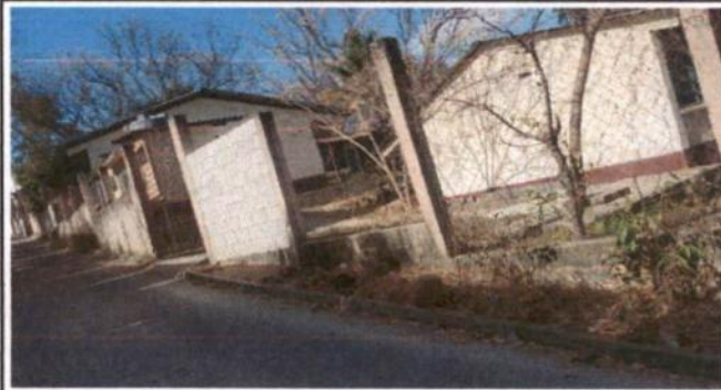
3. MANTENIMIENTO A PORTON
