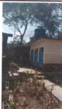
1. PINTURA EN MUROS EXTERIORES E INTERIORES
