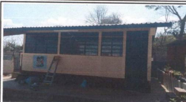
1. PINTURA EN MUROS EXTERIORES E INTERIORES
