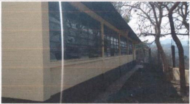
5. VENTANAS 5.1 ELABORACION E INSTALACION DE METAL
