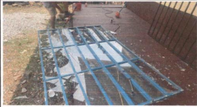
5. VENTANAS 5.1 ELABORACION E INSTALACION DE METAL
