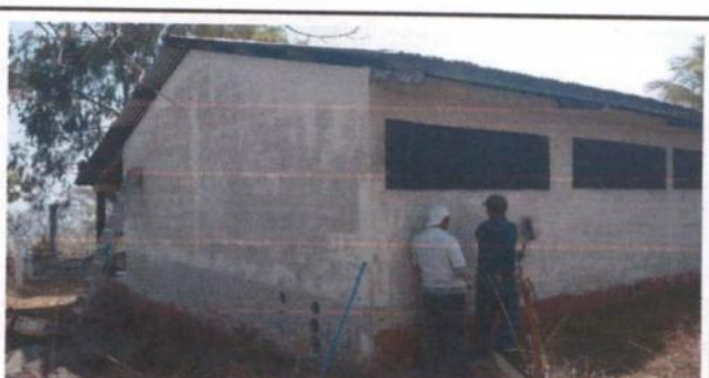
1. PINTURA EN MUROS EXTERIORES E INTERIORES
