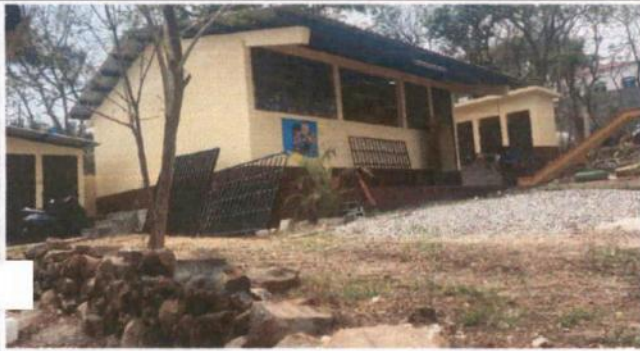
5. VENTANAS 5.1 ELABORACION E INSTALACION DE METAL
