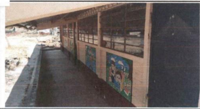
5. VENTANAS 5.1 ELABORACION E INSTALACION DE METAL
