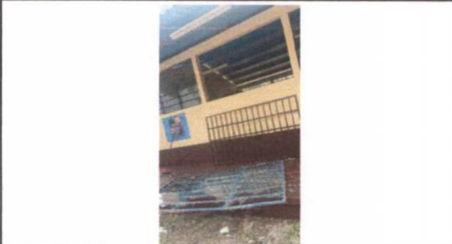
5. VENTANAS 5.1 ELABORACION E INSTALACION DE METAL
