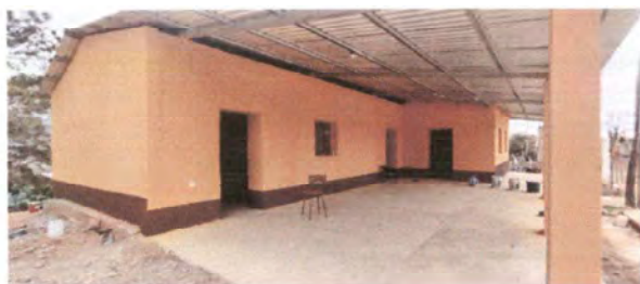
Foto 1: Aulas y corredor
