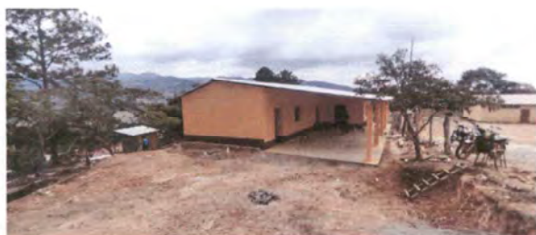
Foto 3: Vista panorámica de la escuela
