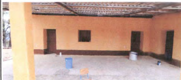
Foto 2: Aulas y corredor
