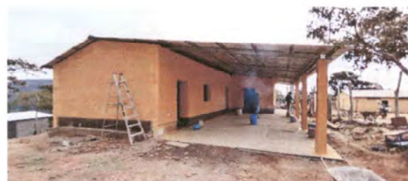
Foto 5: Aulas y corredor
