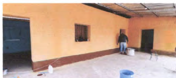
Foto 6: Aulas y corredor
