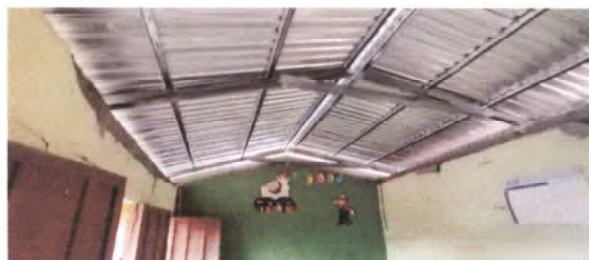
Foto 2: Estructura metálica y techo
