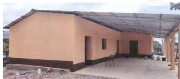
Foto 4: Aulas y corredor
