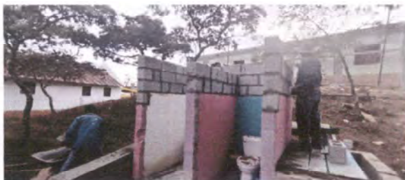
Foto 1: Pegado de block en sanitarios
