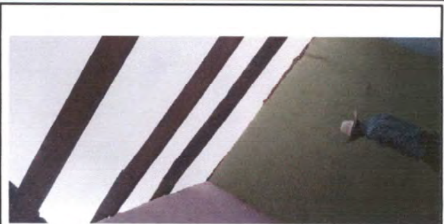
Foto 2: Desinstalación de madera y lámina
