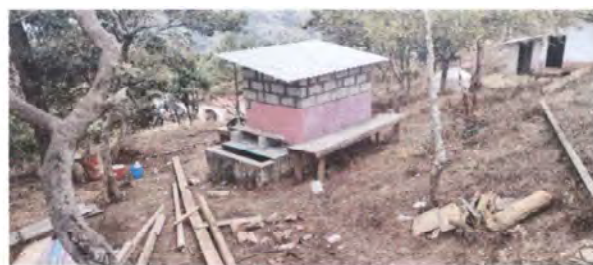
Foto 2: Instalación de lámina en sanitarios
