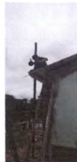
Foto 4: Instalación de lámina troquelada Aluzinc
