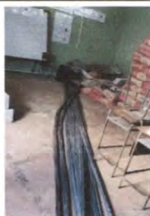
Foto 5: Hierro y cemento para remozamiento
