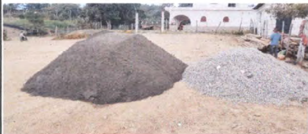
Foto1: Arena y piedrin para remozamiento
