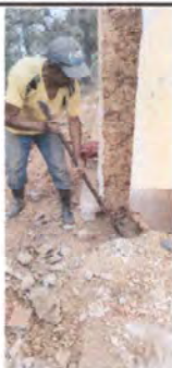
Foto 3: Preparación de muro para instalación de columnas
