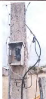
Foto 5: Sustitución de sistema eléctrico
