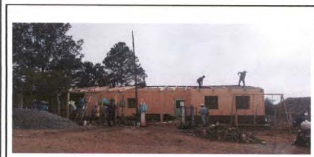
Foto 5: Desinstalación de madera y lámina
