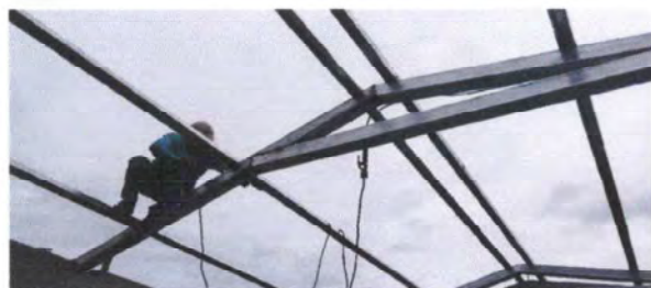
Foto 3: Instalación de estructura metálica para techo
