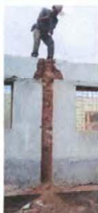
Foto 5: Preparación del muro para instalación de columnas
