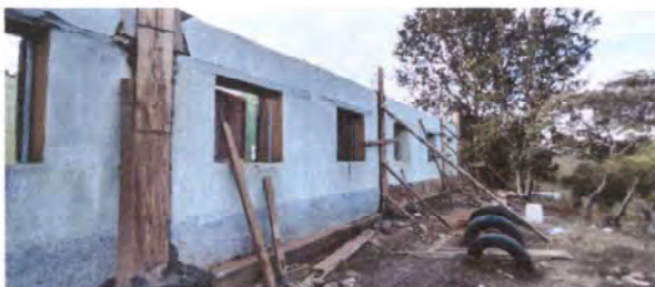
Foto 3: Fundición de columna para base de techo
