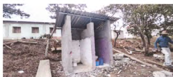
Foto 6: Cernido en sanitarios
