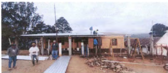
Foto 3: Instalación de lámina troquelada Aluzinc
