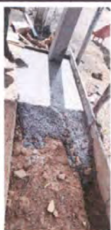
Foto 5: fundición de torta de cemento
