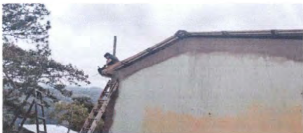
Foto 5: Instalación de lámina troquelada Aluzinc
