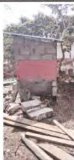
Foto 1: Instalación de lámina en sanitarios
