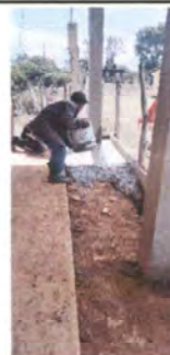
Foto 4: fundición de torta de cemento
