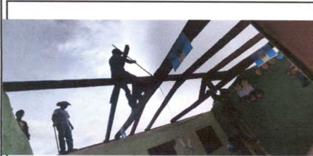
Foto1: Desinstalación de madera y lámina
