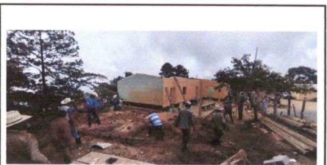
Foto 4: Desinstalación de madera y lámina
