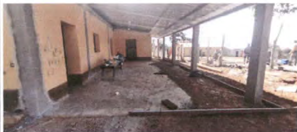
Foto 3: Preparación del suelo para fundición de torta de cemento
