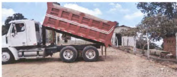
Foto1: Camión descargando material
