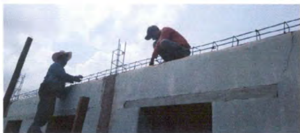
Foto 5: Armadura de hierro para viga
