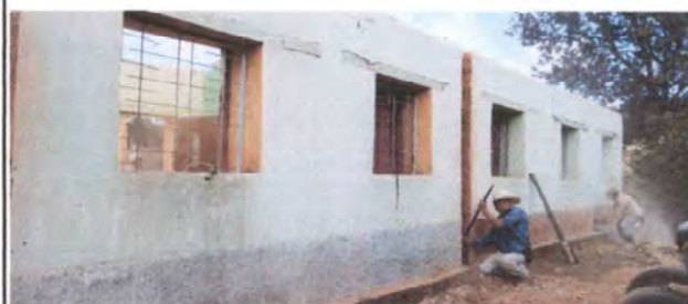
Foto 4: Preparación del muro para instalación de columnas
