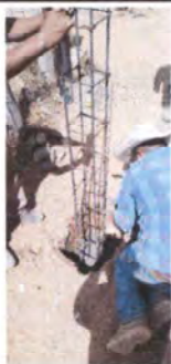
Foto1: Colocación de columnas
