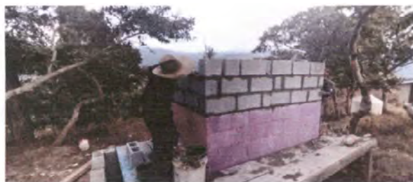
Foto 3: Pegado de block en sanitarios
