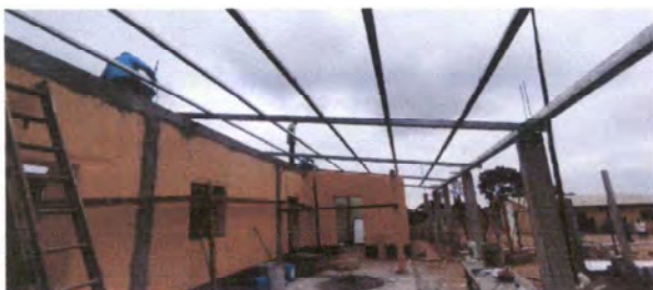
Foto 1: Instalación de estructura metálica para techo
