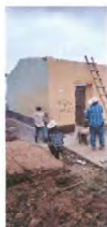
Foto 3: Preparación de muro para instalación de columnas
