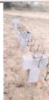
Foto 2: Fabricación de armazón de columnas
