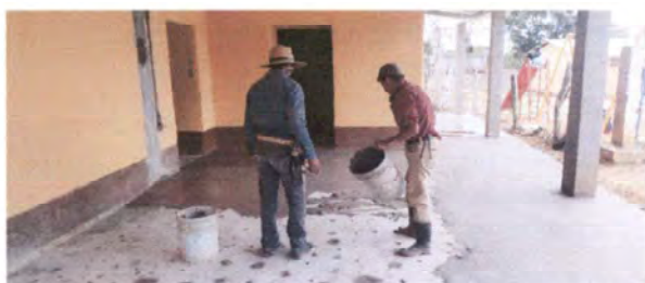
Foto 3: Empastado de torta de cemento
