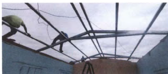
Foto 2: Instalación de estructura metálica para techo
