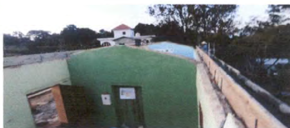
Foto 6: Fundición de viga para techo
