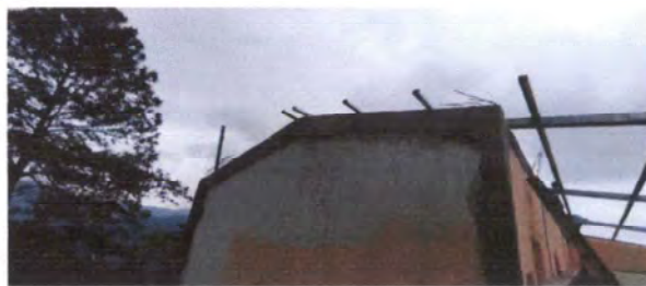
Foto 4: Instalación de estructura metálica para techo
