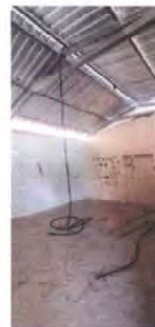
Foto 4: Sustitución de sistema eléctrico
