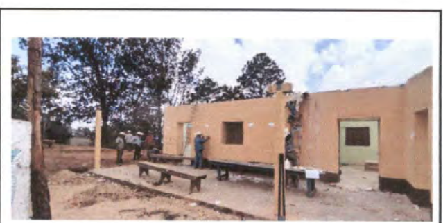
Foto 6: Desinstalación de madera y lámina
