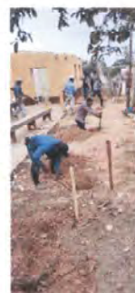
Foto 4: Preparación del suelo para instalación de columnas
