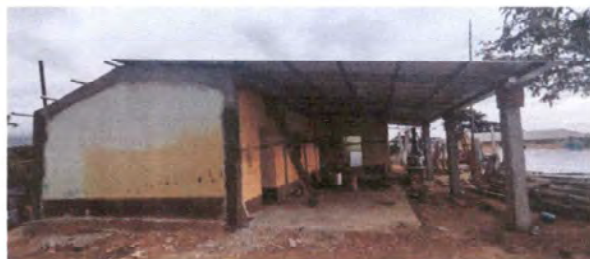
Foto 6: Instalación de lámina troquelada Aluzinc
