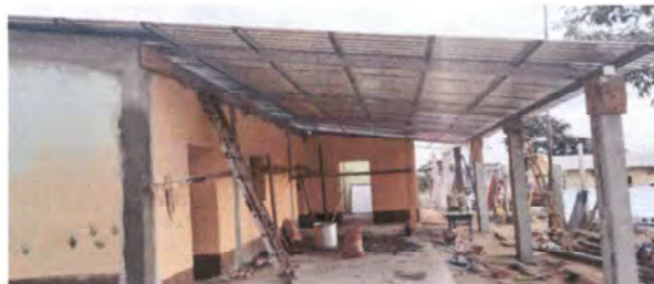
Foto 2: Instalación de lámina troquelada Aluzinc
