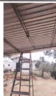
Foto 6: Sustitución de sistema eléctrico
