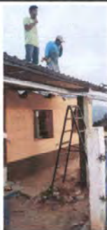
Foto1: Instalación de lámina troquelada Aluzinc
