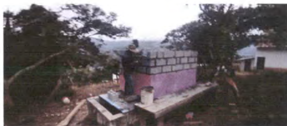
Foto 2: Pegado de block en sanitarios
