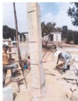
Foto 4: Fundición de columna para base de techo
