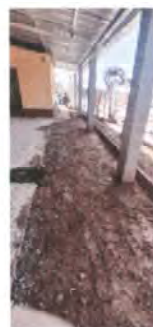
Foto 2: Preparación del suelo para fundición de torta de cemento
