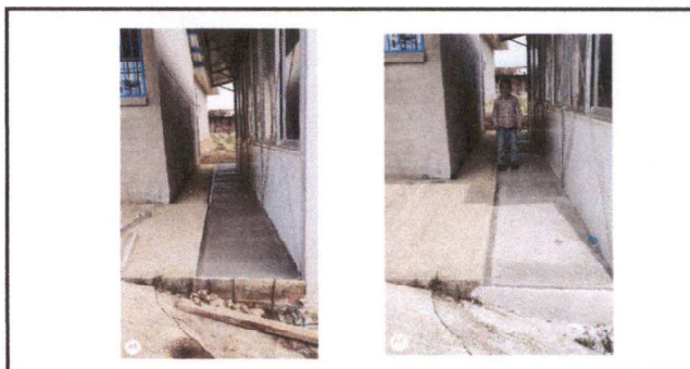
Foto 6: CUNETA DE CONCRETO: REPARACIÓN DE CUNETA DE CONCRETO (6 METROS CUADRADOS).
