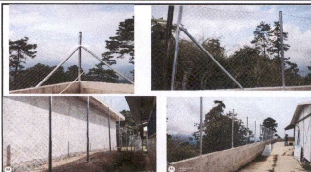
Foto 2: MURO PERIMETRAL: REPARACIÓN DE MURO PERIMETRAL DE BLOCK CON TUBO HG Y MALLA GALVANIZADA (125 M2).
