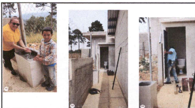
Foto 4: REPARACIÓN DE RED DE DRENAJES Y AGUA: REFORZAMIENTO DE FOSA SÉPTICA, SUSTITUCIÓN DE TUBERÍA PVC LINEA PRINCIPAL AGUAS NEGRAS (3 PULGADAS), RED DE AGUA ENTUBADA, (SUSTITUCIÓN DE TUBERÍA PVC LINEA PRINCIPAL Y SUS ACCESORIOS INSTALACIÓN INCLUIDA).
