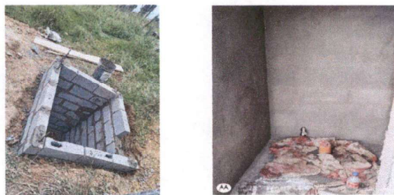
Foto 3: REPARACIÓN DE RED DE DRENAJES Y AGUA: REFORZAMIENTO DE FOSA SÉPTICA, SUSTITUCIÓN DE TUBERÍA PVC LINEA PRINCIPAL AGUAS NEGRAS (3 PULGADAS). RED DE AGUA ENTUBADA, (SUSTITUCIÓN DE TUBERÍA PVC LINEA PRINCIPAL Y SUS ACCESORIOS INSTALACIÓN INCLUIDA).
