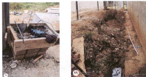
Foto 4: REPARACIÓN DE RED DE DRENAJES Y AGUA: REFORZAMIENTO DE FOSA SÉPTICA, SUSTITUCIÓN DE TUBERÍA PVC LINEA PRINCIPAL AGUAS NEGRAS (3 PULGADAS). RED DE AGUA ENTUBADA, (SUSTITUCIÓN DE TUBERÍA PVC LINEA PRINCIPAL Y SUS ACCESORIOS INSTALACIÓN INCLUIDA).
