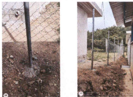
Foto 2: MURO PERIMETRAL: REPARACIÓN DE MURO PERIMETRAL DE BLOCK CON TUBO HG Y MALLA GALVANIZADA (125 M2).
