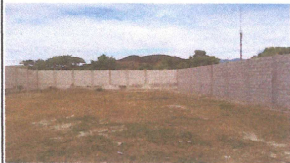
Foto 2: Muro perimetral reparado
