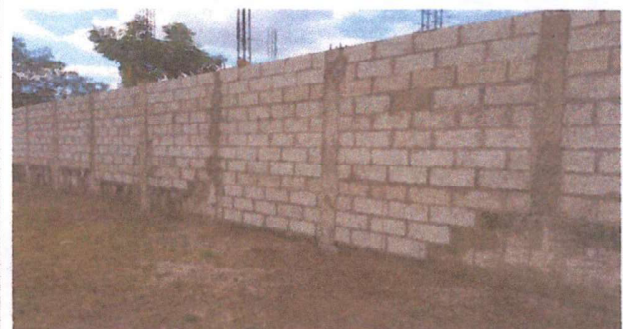
Foto 4: Muro perimetral reparado y ampliado
