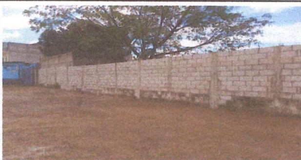
Foto 5: Muro perimetral reparado y ampliado
