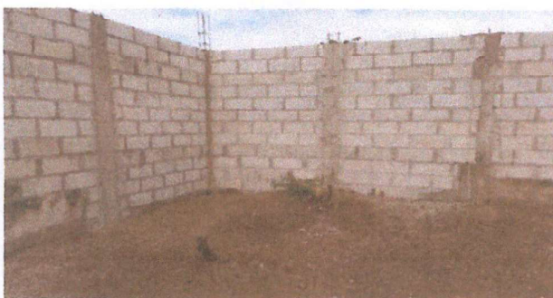
Foto 3: Muro perimetral reparado y ampliado
