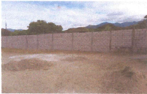
Foto 1: Muro perimetral reparado
