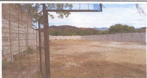
Foto 6: Vista panorámica muro perimetral reparado y ampliado
