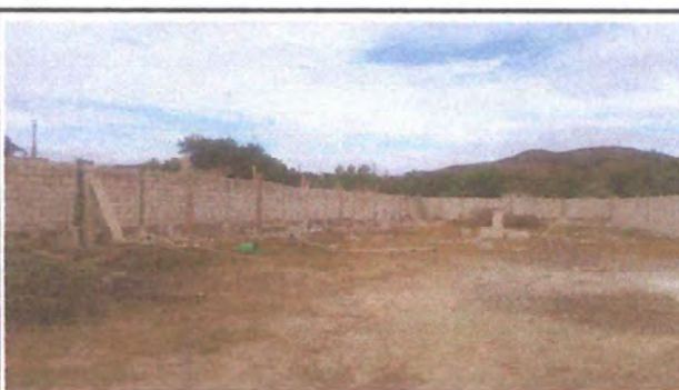
Foto 4: Escombros en la obra
