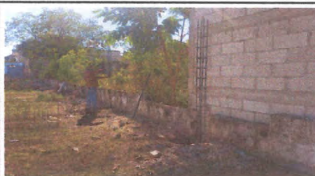
Foto 4: Colocación de columnas sección 3
