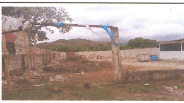
Foto 6: Muro en reparación sección 3
