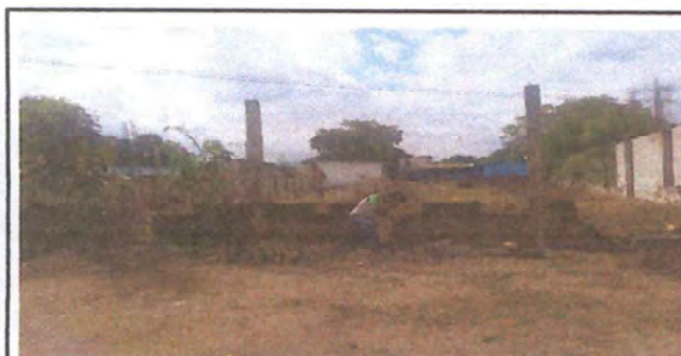
Foto 5: Sanjeo de columnas de refuerzo
