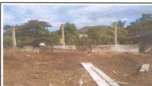
Foto 4: Retiro de malla y limpieza sección 2 del muro
