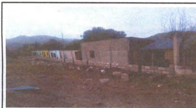
Foto 3: Reparación de muro perimetral
