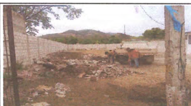
Foto 6: Extracción de ripio
