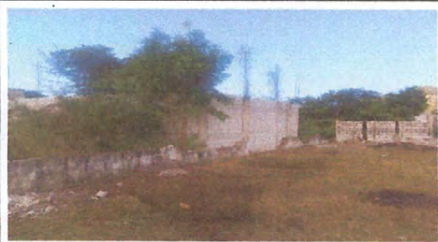
Foto 1: Limpieza de la sección 3 del muro
