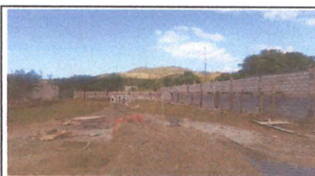
Foto 6: Muro en reparación, secciones 1 y 2
