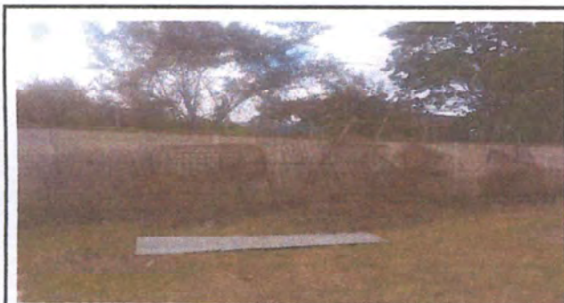
Foto 3: Resguardo de la electromalla retirada del muro
