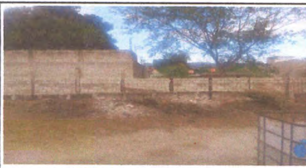
Foto 5: Reparación y ampliación de muro perimetral sección 3
