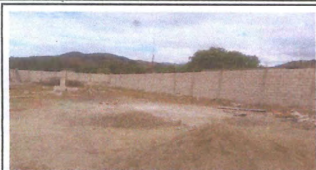
Foto 1: Obra con residuos del trabajo
