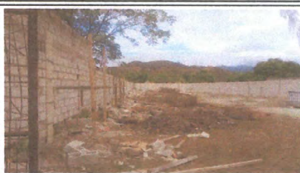
Foto 2: Escombros después de la obra
