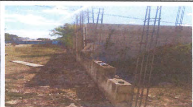
Foto 3: Colocación de columnas sección 3
