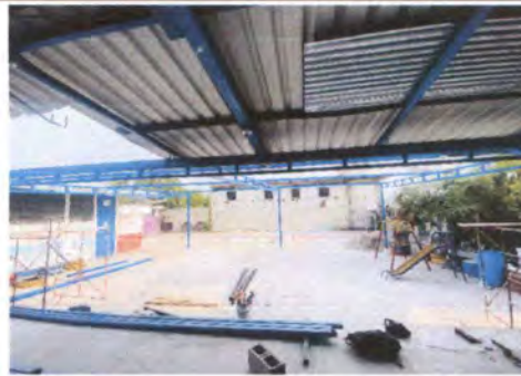
Foto2: ESTRUCTURA DE TECHO: Estructura metálica con tubería de 3*3 y de 2*2 con Joist y carga, lámina de costanera de 3*2 más enlaminado con lámina troquelada calibre 26
