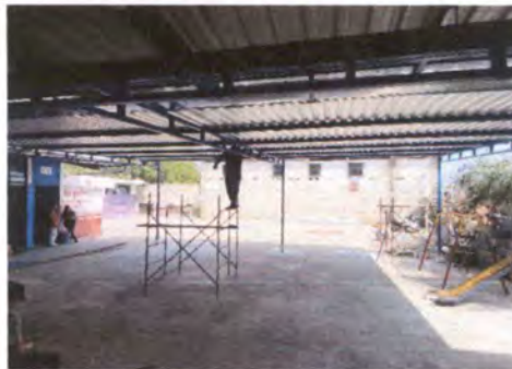
Foto 4: CUBIERTA DE LÁMINA: Estructura metálica con tubería de 3*3 y de 2*2 con Joist y carga, lámina de costanera de 3*2 más enlaminado con lámina troquelada calibre 26
