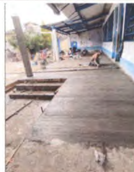
Foto 4: PISO: Fundición de contrapiso de 5 cms en área de pasillos del instituto y ampliación de escenario existente
