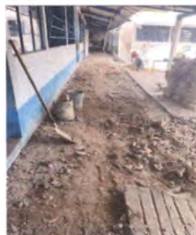
Foto 2: PISO: Fundición de contrapiso de 5 cms en área de pasillos del instituto y ampliación de escenario existente
