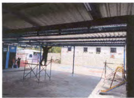
Foto 3: CUBIERTA DE LÁMINA: Estructura metálica con tubería de 3*3 y de 2*2 con Joist y carga, lámina de costanera de 3*2 más enlaminado con lámina troquelada calibre 26
