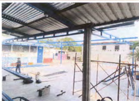
Foto1: ESTRUCTURA DE TECHO: Estructura metálica con tubería de 3*3 y de 2*2 con Joist y carga, lámina de costanera de 3*2 más enlaminado con lámina troquelada calibre 26
