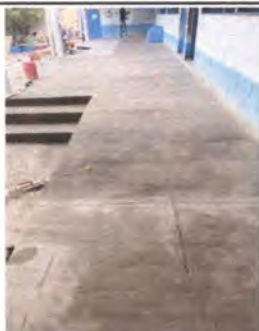
Foto 5: PISO: Fundición de contrapiso de 5 cms en área de pasillos del instituto y ampliación de escenario existente
