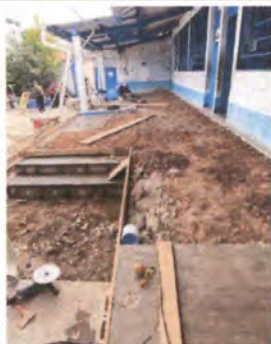
Foto 3: PISO: Fundición de contrapiso de 5 cms en área de pasillos del instituto y ampliación de escenario existente
