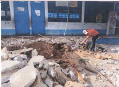
Foto 1: PISO: Fundición de contrapiso de 5 cms en área de pasillos del instituto y ampliación de escenario existente
