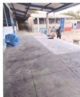
Foto 6: PISO: Fundición de contrapiso de 5 cms en área de pasillos del instituto y ampliación de escenario existente
