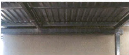
Foto 5: SUSTITUCIÓN DE LÁMINA POR LÁMINA TROQUELADA
