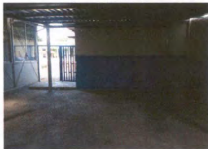
Foto 1: REPARACIÓN DE PISO DE LOSA
