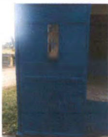
Foto 1: REPARACIÓN DE PUERTA DE INGRESO
