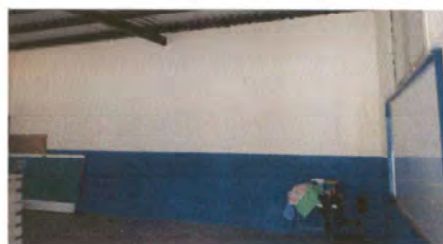
Foto 2: PINTURA EN MUROS EXTERIORES E INTERIORES
