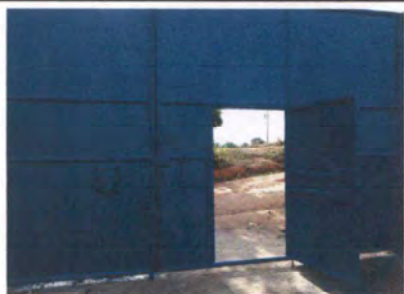
Foto 3: REPARACIÓN DE PORTON PRINCIPAL
