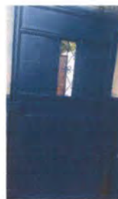
Foto 6: REPARACIÓN DE PUERTA DE INGRESO
