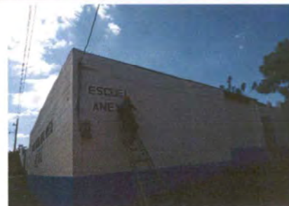
Foto 2: PINTURA EN MUROS EXTERIORES E INTERIORES
