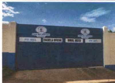
Foto 2: REPARACIÓN DE PORTON PRINCIPAL
