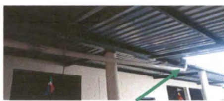
Foto 6: SUSTITUCIÓN DE CANAL DE METAL
