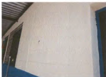
Foto 3: PINTURA EN MUROS EXTERIORES E INTERIORES
