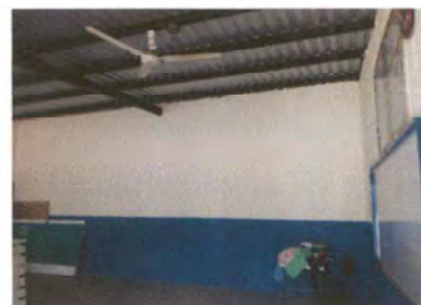
Foto 4: SUSTITUCIÓN DE LÁMINA POR LÁMINA TROQUELADA
