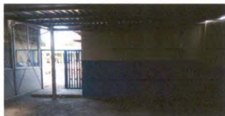
Foto 5: REPARACIÓN DE GALERA
