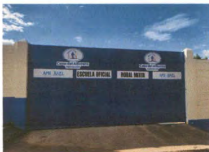
Foto 3: REPARACIÓN DE PORTÓN PRINCIPAL
