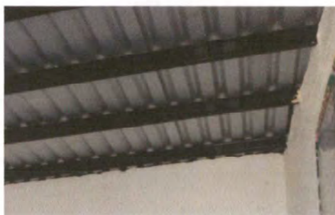
Foto 4: SUSTITUCIÓN DE LÁMINA POR LÁMINA TROQUELADA
