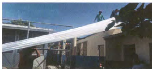
Foto 4: SUSTITUCIÓN DE LÁMINA POR LÁMINA TROQUELADA
