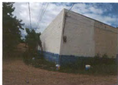
Foto 1: PINTURA EN MUROS EXTERIORES E INTERIORES
