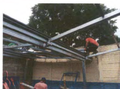
Foto 2: REPARACIÓN DE GALERA
