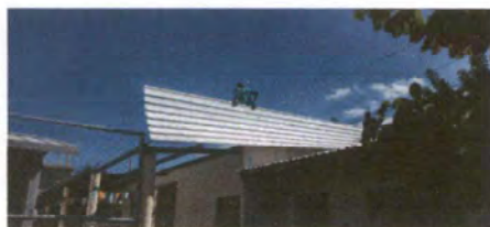
Foto 5: SUSTITUCIÓN DE LÁMINA POR LÁMINA TROQUELADA
