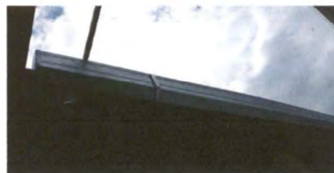
Foto 6: SUSTITUCIÓN DE CANAL Y BAJADA DE AGUA PLUVIAL
