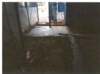
Foto 2: REPARACIÓN DE PISO DE LOSA
