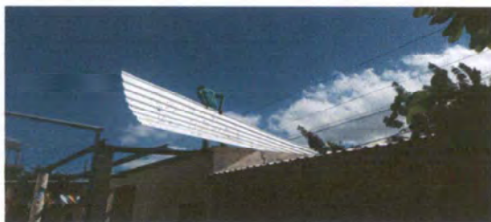
Foto 3: SUSTITUCIÓN DE LÁMINA POR LÁMINA TROQUELADA
