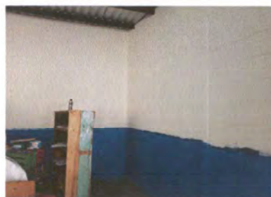
Foto 4: PINTURA EN MUROS EXTERIORES E INTERIORES
