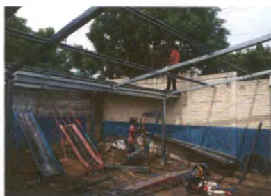
Foto 3: REPARACIÓN DE GALERA
