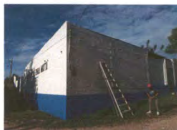
Foto 4: PINTURA EN MUROS EXTERIORES E INTERIORES
