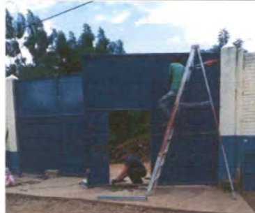
Foto 2: REPARACIÓN DE PORTON PRINCIPAL
