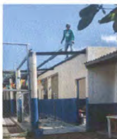
Foto 3: SUSTITUCIÓN DE LÁMINA POR LÁMINA TROQUELADA
