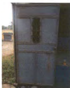
Foto 1: REPARACIÓN DE PUERTA DE INGRESO
