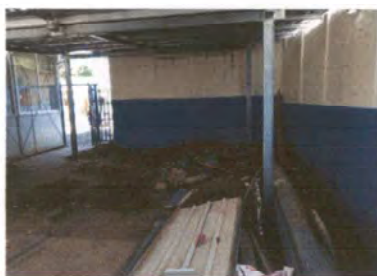
Foto 1: REPARACIÓN DE PISO DE LOSA
