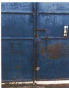
Foto 3: REPARACIÓN DE PORTON PRINCIPAL
