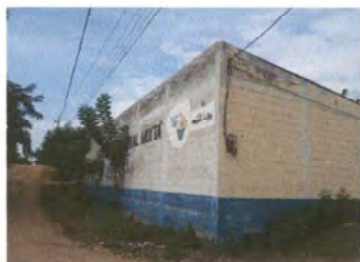
Foto1: PINTURA EN MUROS DE EXTERIORES E INTERIORES
