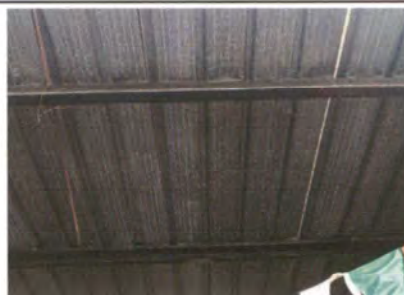
Foto 4: SUSTITUCIÓN DE LÁMINA POR LÁMINA TROQUELADA
