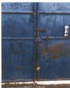
Foto 3: REPARACIÓN DE PORTON PRINCIPAL
