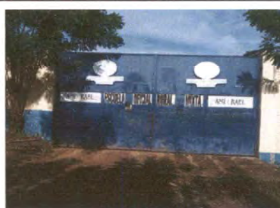
Foto 2: REPARACIÓN DE PORTON PRINCIPAL
