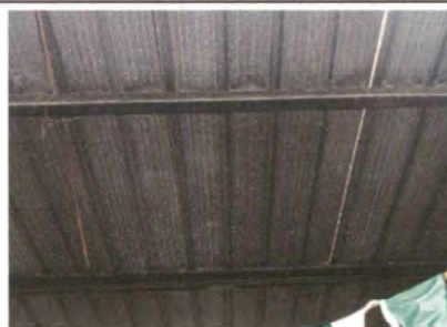
Foto 4: SUSTITUCIÓN DE LÁMINA POR LÁMINA TROQUELADA
