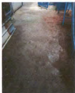
Foto 1: REPARACIÓN DE PISO DE LOSA
