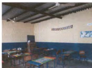
Foto 2: PINTURA EN MUROS DE EXTERIORES E INTERIORES
