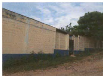
Foto 6: PINTURA DE EXTERIORES
