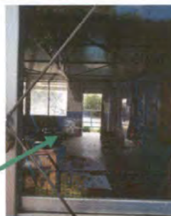
Foto 2: REPARACIÓN DE VENTANAS DE VIDRIO
