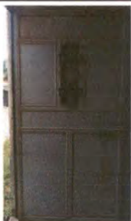
Foto 1: REPARACIÓN DE PUERTA DE INGRESO
