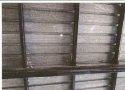
Foto 5: SUSTITUCIÓN DE LÁMINA POR LÁMINA TROQUELADA
