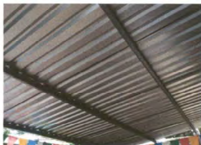
Foto 5: REPARACIÓN DE GALERA
