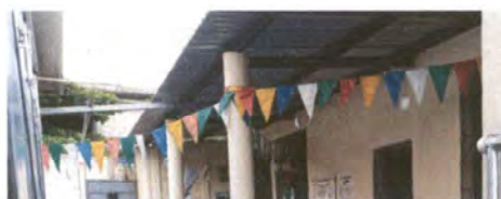
Foto 6: SUSTITUCIÓN DE CANAL DE METAL
