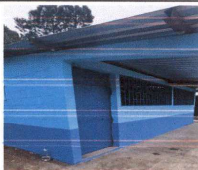
SUSTITUCIÓN DE PUERTA DE METAL
