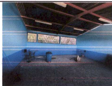
SUSTITUCIÓN DE PISO DE GRANITO
