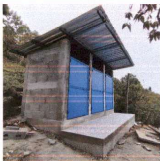
AMPLIACIÓN DE MURO PERIMETRAL DE BLOCK
