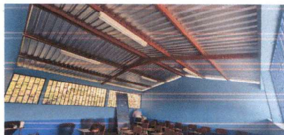
SUSTITUCIÓN DE LÁMINA
