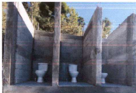
SUSTITUCION DE INODOROS
