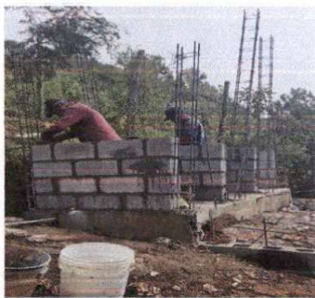
AMPLAICION DE MURO PERIMETRAL DE BLOCK
