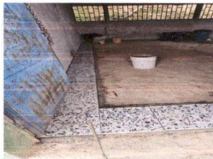
SUSTITUCION DE PISO DE DE GRANITO
