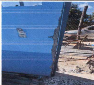
SUSTITUCIÓN DE PUERTA DE METAL
