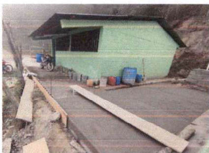
REPARACION DE PLANCHAS DE CONCRETO DE PATIO
