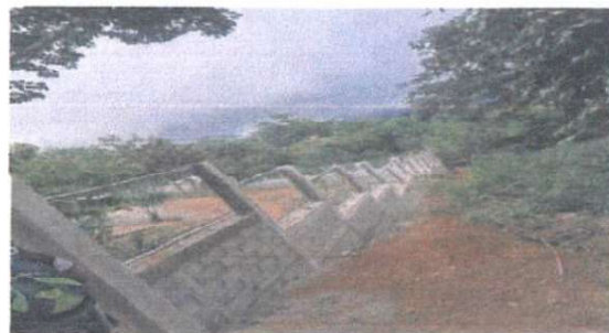
LATERALIDAD DERECHA DEL MURO
