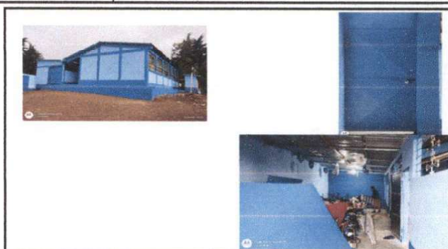
Foto 2: PINTURA EN MUROS EXTERIORES E INTERIORES
