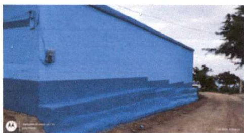
Foto 5: REPARACIÓN DE MUROS DE CONTENCIÓN. Reparación y Aplicación de sabieta en banquetas de concreto en interior y exterior del establecimiento educativo.
