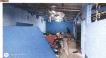
Foto 2: PINTURA EN MUROS EXTERIORES E INTERIORES
