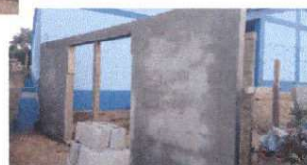
Foto 6: MURO. Reforzamiento y mampostería en paredes de portón de ingreso en muro perimetral de block
