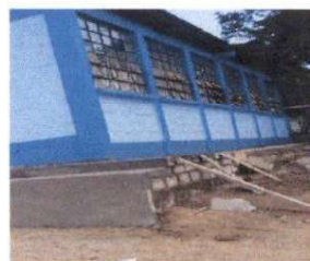
Foto 4: REPARACIÓN DE MUROS DE CONTENCIÓN. Reparación y Aplicación de sabieta en banquetas de concreto en interior y exterior del establecimiento educativo.
