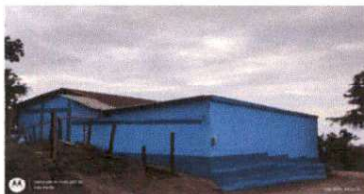
Foto 3: PINTURA EN MUROS EXTERIORES E INTERIORES
