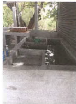
Foto 2: SUSTITUCION DE PILA O TANQUE
