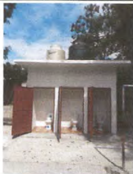
Foto 1: REPARACION DE BAÑOS O SANITARIOS
