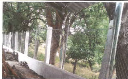
Foto 6: REPARACION DE MURO PERIMENTRAL
