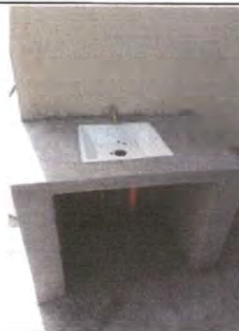
Foto 4: SUSTITUCION DE LAVAMOS
