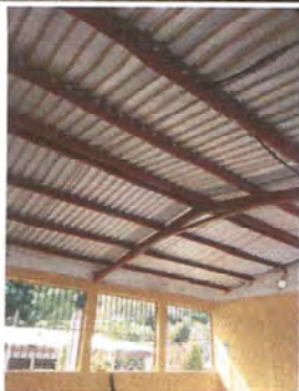
Foto 7: SUSTITUCION DE LAMINA
