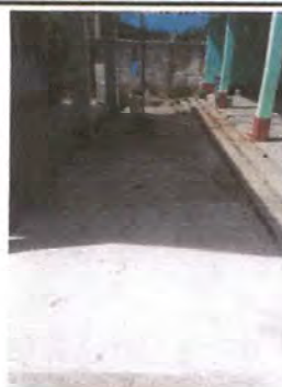
Foto 8: SUSTITUCION DE LOSA DE CONCRETO
