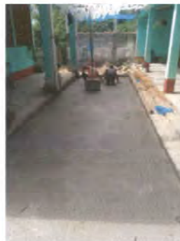
Foto 8: SUSTITUCION DE LOSA DE CONCRETO
