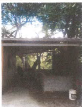
Foto 3: SUSTITUCION DE TECHO
