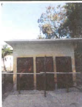
Foto 1: REPARACION DE BAÑOS O SANITARIOS
