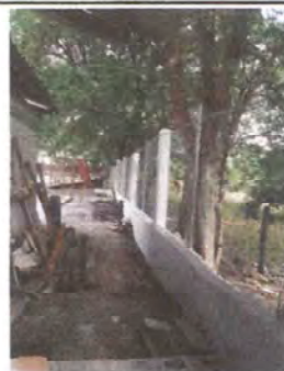
Foto 6: REPARACION DE MURO PERIMENTAL
