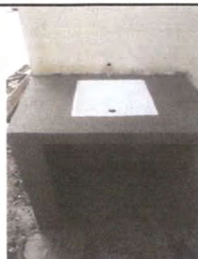
Foto 4: SUSTITUCION DE LAVAMOS
