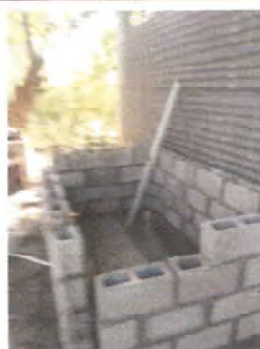
Foto 2: SUSTITUCION DE PILA O TANQUE
