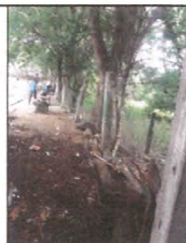
Foto 6: REPARACION DE MURO PERIMENTRAL
