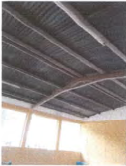
Foto 7: SUSTITUCION DE LAMINA
