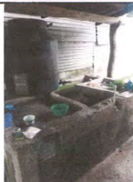
Foto 2: SUSTITUCION DE PILA O TANQUE
