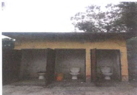
Foto 1: REPARACION DE BAÑOS O SANITARIOS
