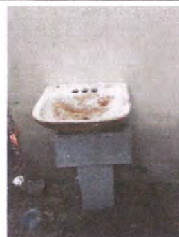
Foto 4: SUSTITUCION DE LAVAMOS
