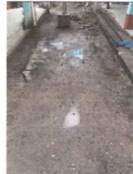
Foto 8: SUSTITUCION DE LOSA DE CONCRETO
