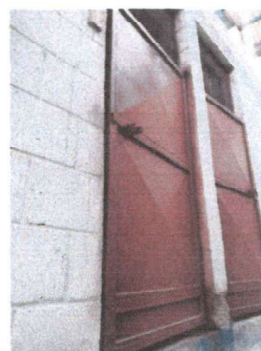
Foto 4: REPARACION DE PUERTAS
