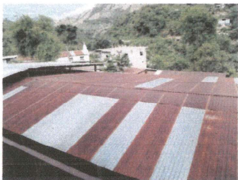
Foto 1: SUSTITUCION DE TECHO EN MAL ESTADO
