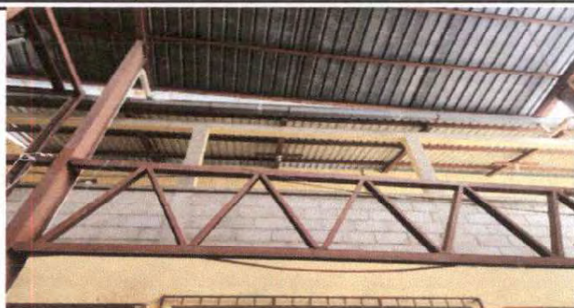
Foto 2: Canales de techo de recreo reparados
