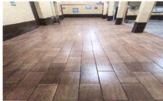
Foto 4: Piso de corredor instalado y en buen estado.
