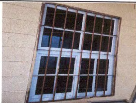
Foto 3: Ventanas nuevas de aulas instaladas
