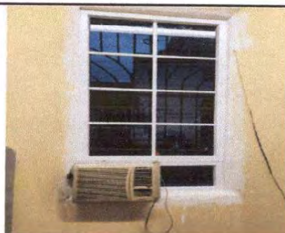
Foto 6: Ventana PVC de Dirección instalada.
