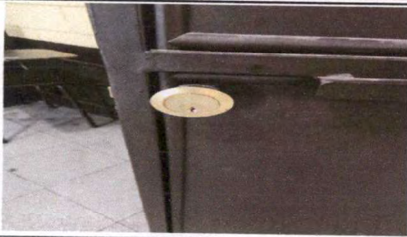
Foto 1: Chapas instaladas en buen estado
