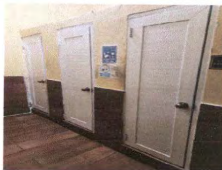
Foto 4: Puertas nuevas de servicios sanitarios de varones instaladas
