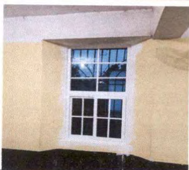
Foto 1: Ventanas PVC nuevas de aulas del centro educativo instaladas
