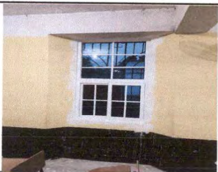
Foto 5: Ventanas PVC nuevas instaladas en las aulas
