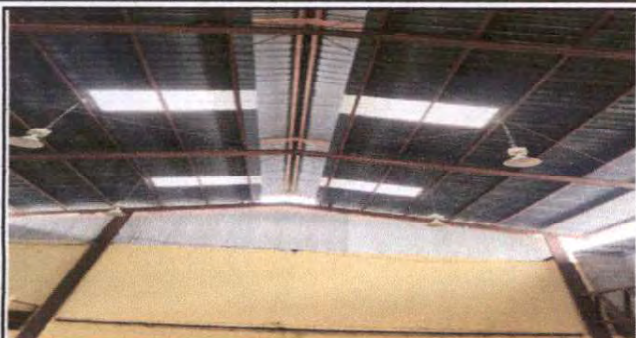
Foto 1: Techo de patio de recreo reparado, incluye cambio de láminas traslúcidas
