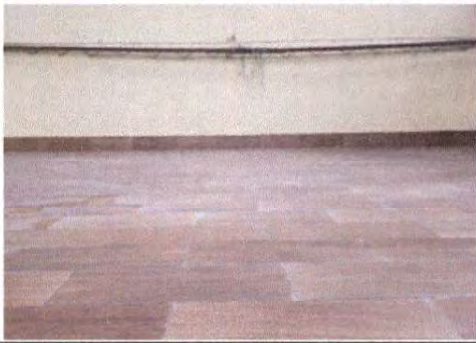
Foto1: Piso escenario instalado
