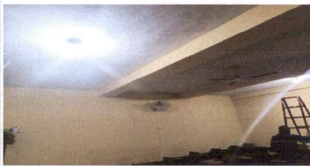
Foto 1: Cableado eléctrico de aulas sustituido
