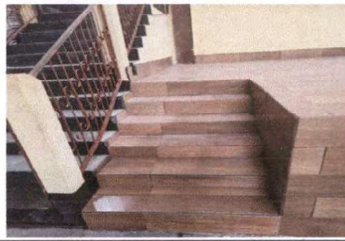
Foto 2: Piso de frente y gradas de escenario instalado
