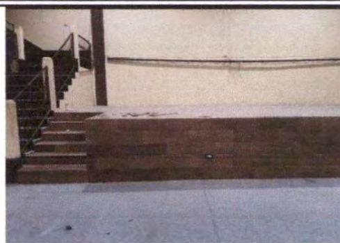
Foto 2: Instalando piso en el frente y gradas de escenario.
