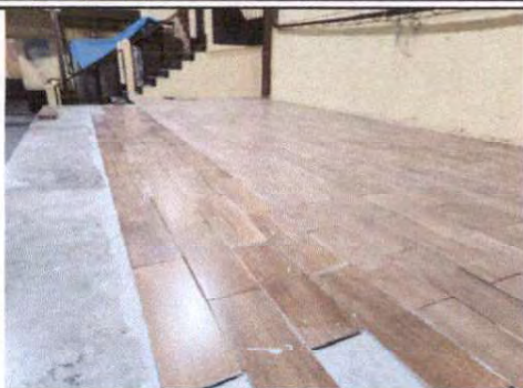
Foto 1: Instalando piso en el escenario del centro educativo
