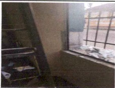
Foto 1: Ventana antigua desinstalada.
