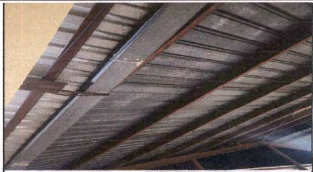
Foto 2: Reparación de techo y canales patio de recreo
