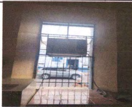
Foto 2: Desinstalación de ventana de Secretaria del plantel
