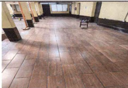
Foto 4: Instalando piso en corredores del centro educativo
