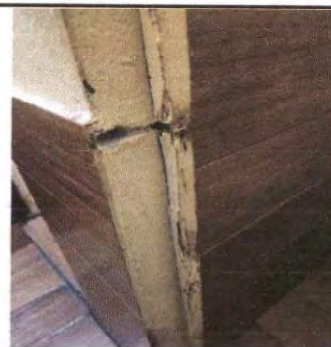
Foto 4: Se quitaron puertas antiguas de servicios sanitarios de varones
