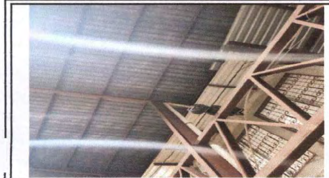
Foto1: Reparación de techo patio de recreo
