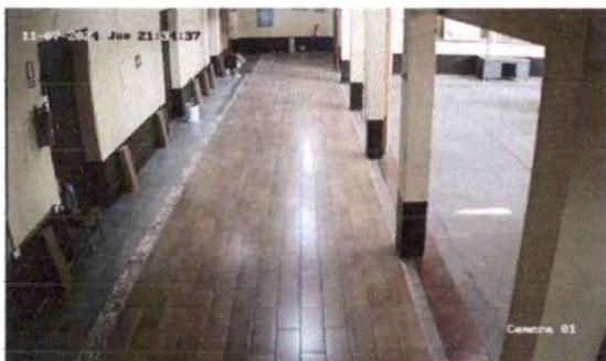
Foto 3: Instalando piso encorredor del centro educativo
