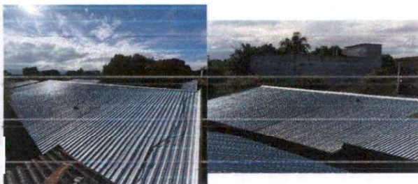
Foto 1: Sustrución de duralita en mal estado en siete aulas del módulo uno y dos aulas del módulo dos del edificio escolar.
