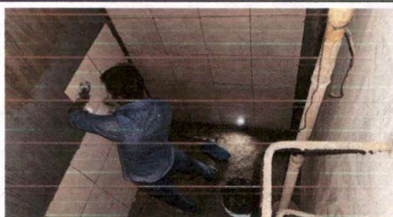
Foto 2: Instalación de piso tipo azulejo en cisterna de agua para resanado de muros.
