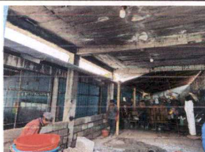
Foto 4: Instalación de muros para aula de sexto grado con acabados ubicada en el módulo tres del edificio escolar.
