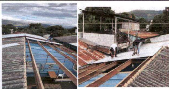
Foto1: Sustitución de duralita en mal estado en siete aulas del módulo uno y dos aulas del módulo dos del edificio escolar.
