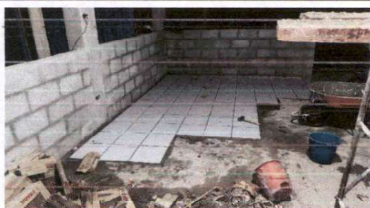
Foto 3: Instalación de piso cerámico para aula de quinto grado ubicada en el módulo tres del edificio escolar.
