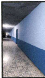
FOTO 2: FASE FINAL DE PINTURA DEL MURO INTERIOR DE LAS AULAS.
