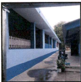
Foto 1: FASE FINAL DE LA PINTURA DE LAS PAREDES DE LAS AULAS FRENTE A LA ESCUELA DE PREPRIMARIA.
