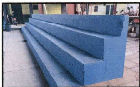
Foto 3: PINTURA DE LAS GRADAS DE LA CANCHA DE LA ESCUELA.
