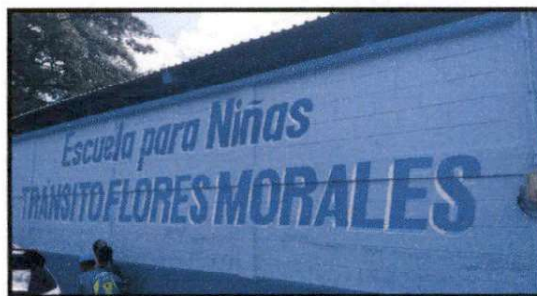
Foto 4: PINTURA DEL MURO PERIMETRAL EXTERIOR DE LA ESCUELA.
