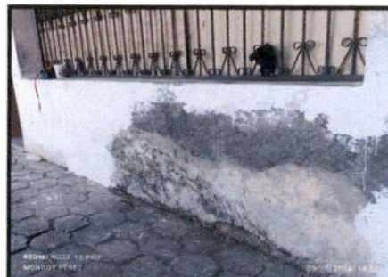
FOTO 2: REPARACIÓN DEL REPELLO DE LA PARED TRASERA DE LAS AULAS DE LA ESCUELA.
