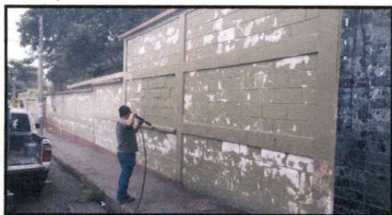
Foto 1: LAVADO DE PAREDES DEL MURO PERIMETRAL EXTERIOR PARA PODER APLICAR LA PINTURA.
