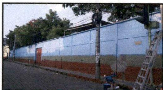
Foto 3: PINTURA DEL MURO PERIMETRAL EXTERIOR DE LA ESCUELA.
